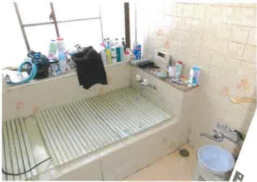
物件2:1階浴室の状況
