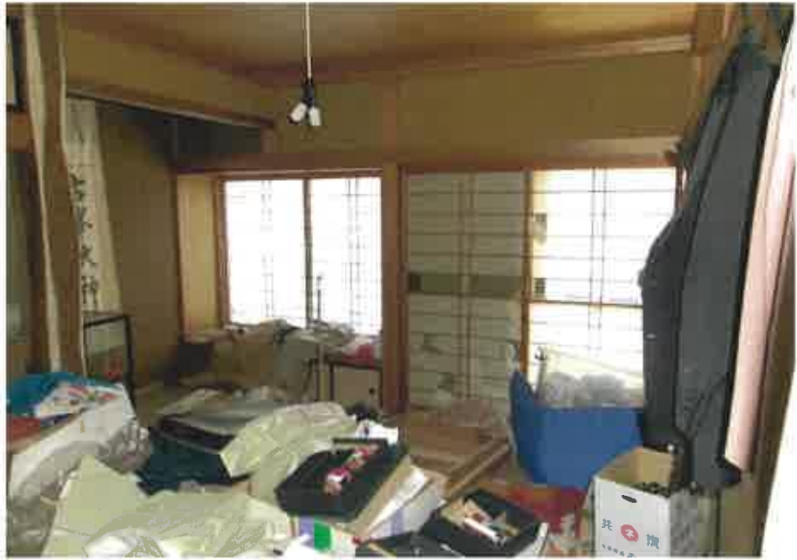
物件2:1階北側和室の状況
