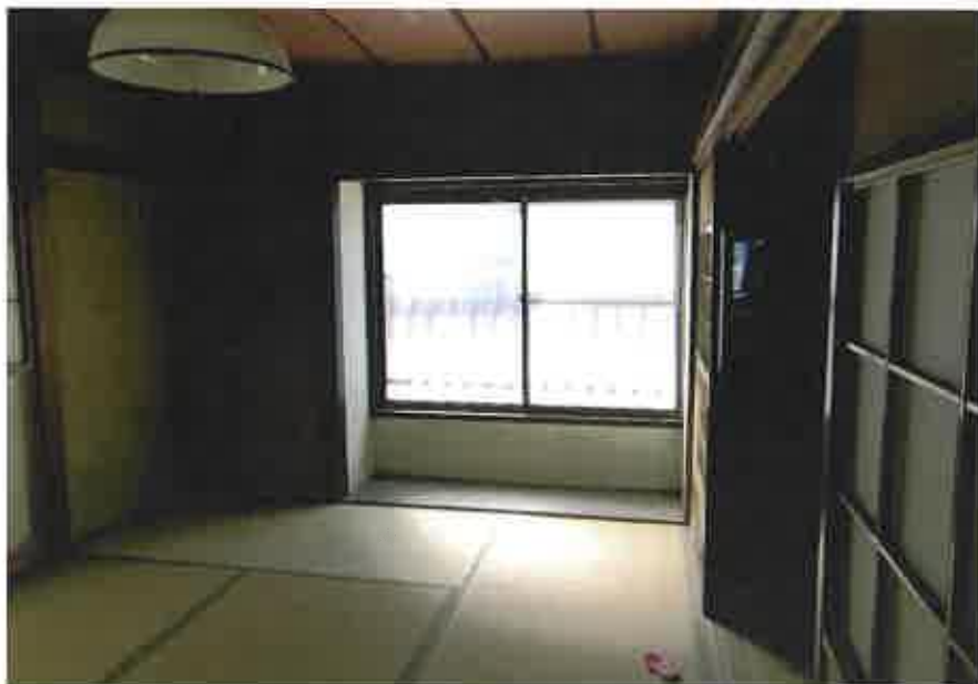
物件2主である建物:1階南西側和室の状況
