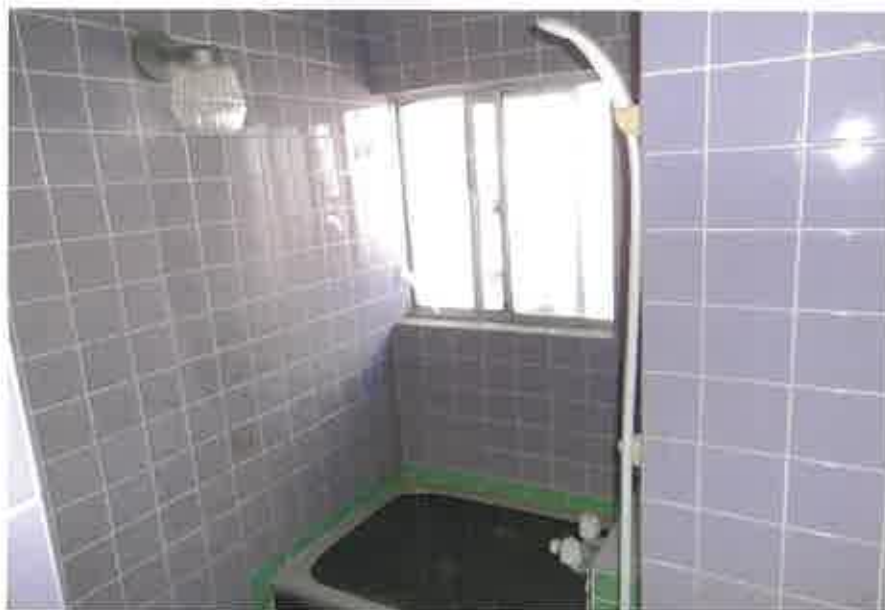
物件2主である建物:1階浴室の状況
