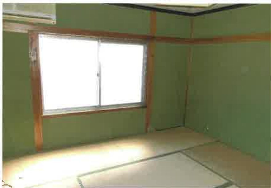
物件2主である建物:2階南側和室の状況
