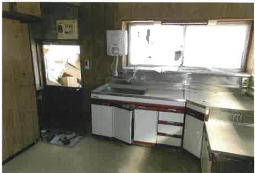
物件2主である建物:1階台所の状況
