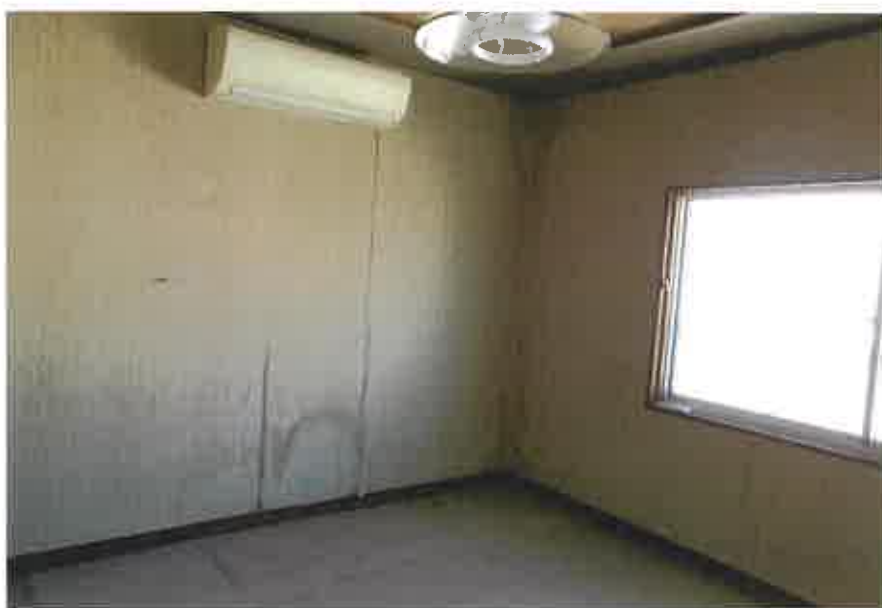
物件2主である建物:2階北側洋室の状況
