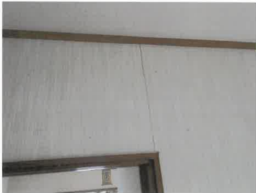
物件3:2階廊下の壁の亀裂
