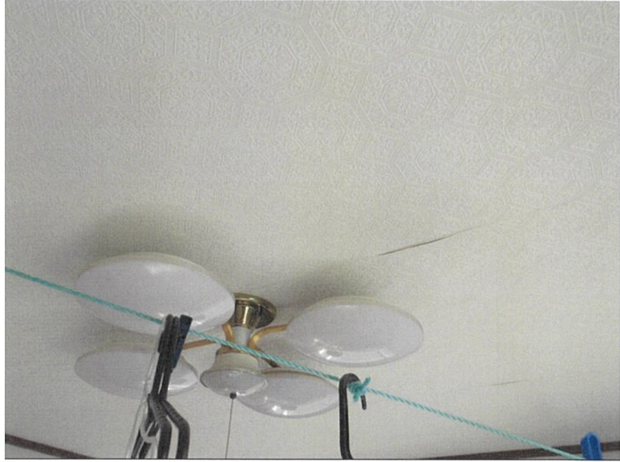
物件2:2階東側洋室の天井クロスの剥がれ
