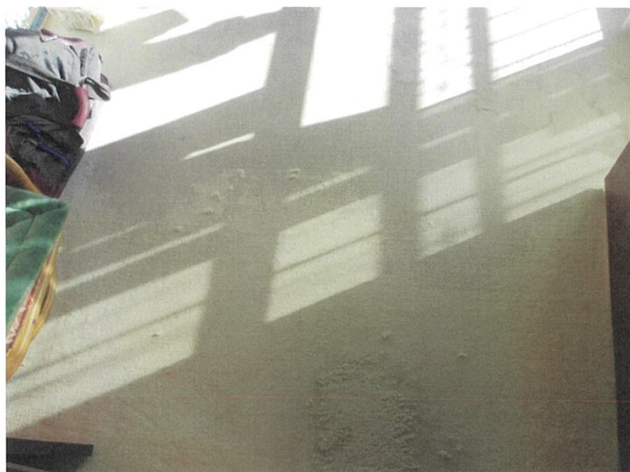
物件2：2階東側洋室の床カーペットの擦れ
