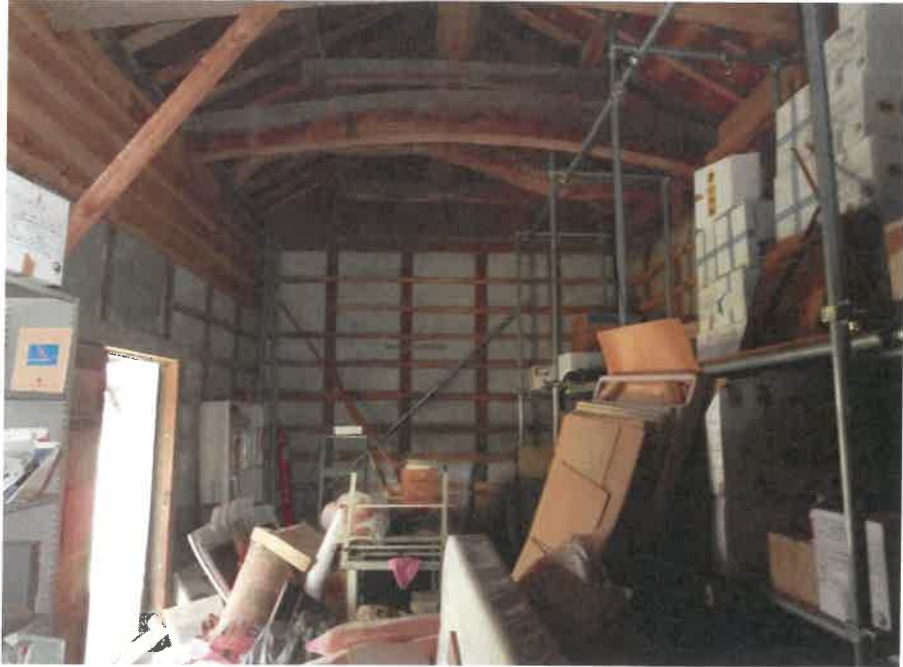
物件10未登記附属建物2の内部の状況
