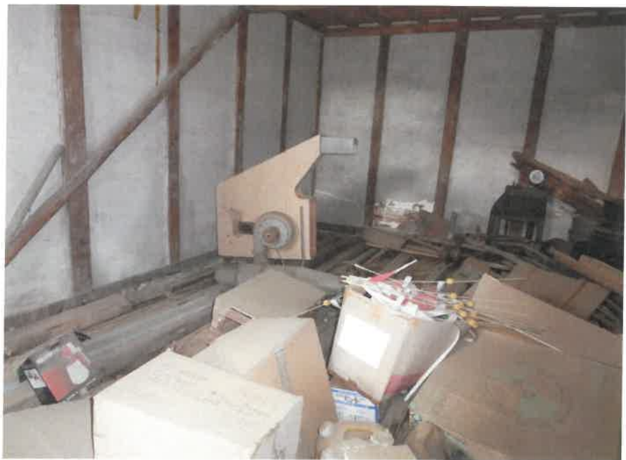
物件 1 0 未登記附属建物 1 の内部の状況
