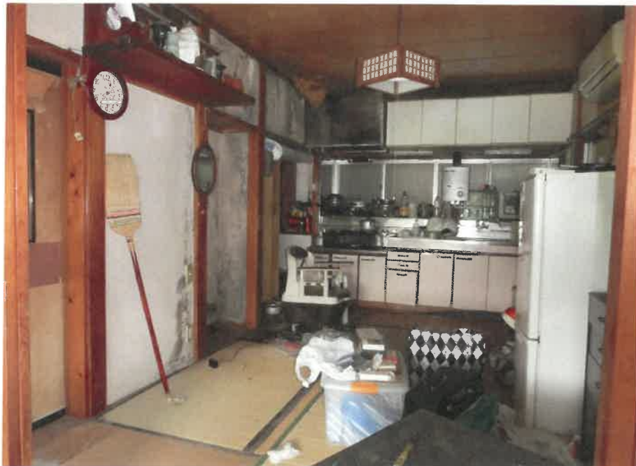
物件11建物の内部の状況（1階部分）
