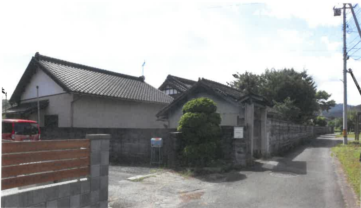
物件 1 2 及び附属建物の状況
