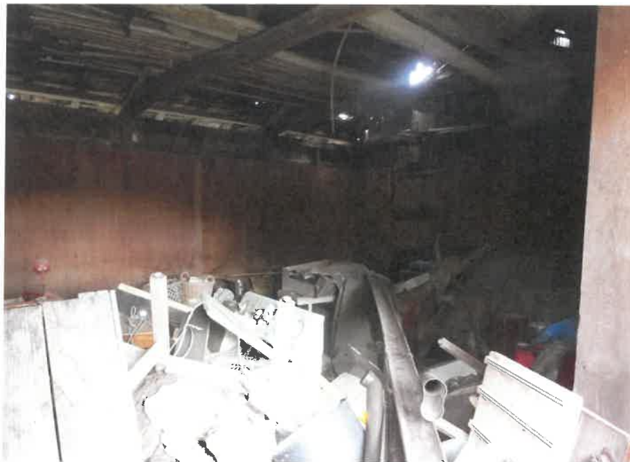
物件1 2 附属建物符号2 の内部の状況
