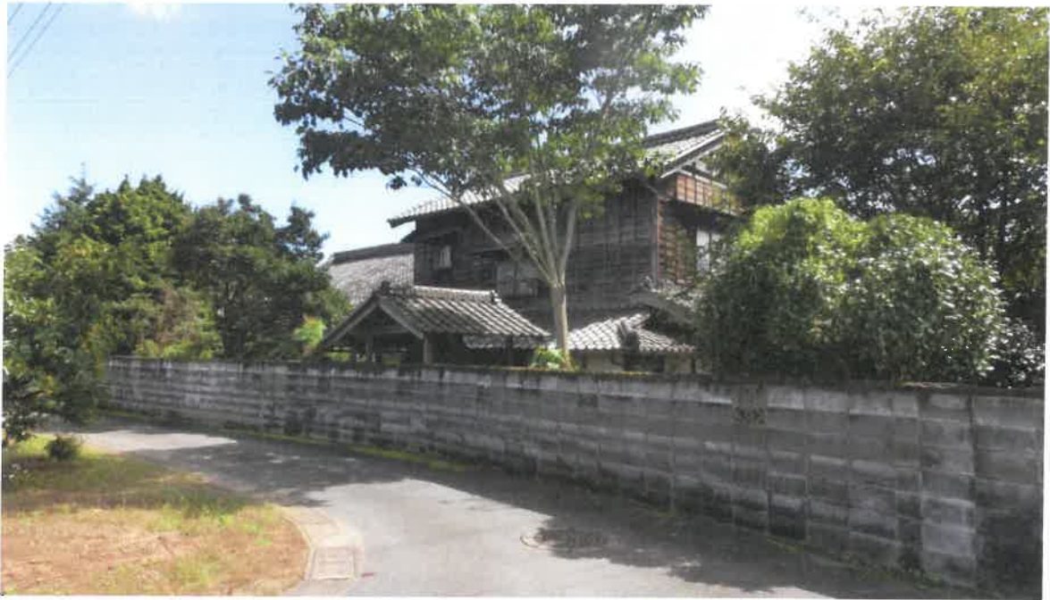
物件 1 2 及び附属建物符号 1, 祠の状況
