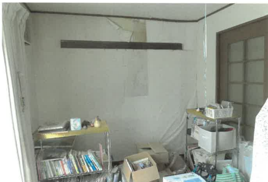
物件10:1階101の洋室の状況
