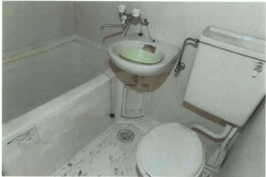
物件10:1階103の3点ユニットバスの状況
