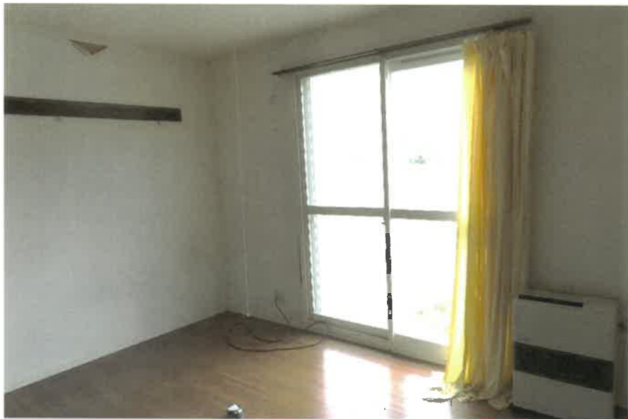
物件10:1階104の洋室の状況
