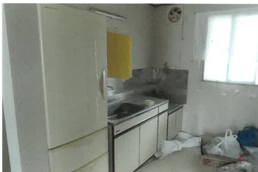
物件10:1階101の台所の状況
