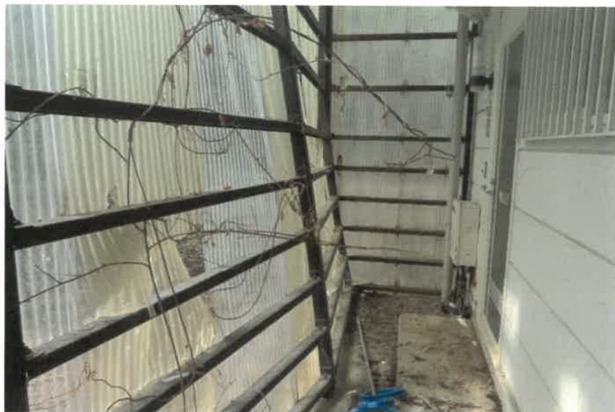
物件10:1階外廊下の状況
