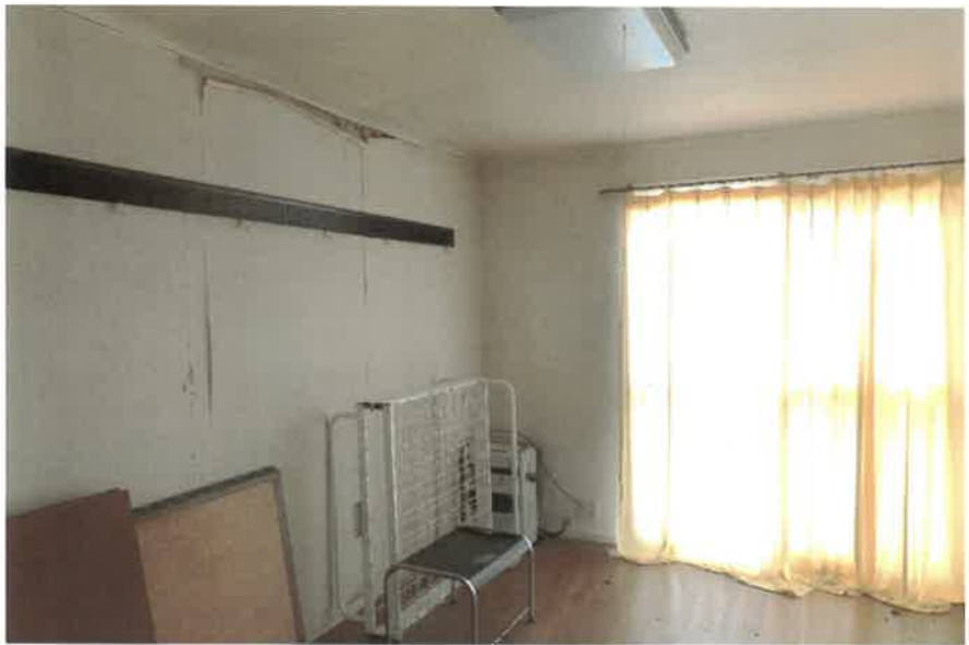
物件10:2階204の洋室の状況
