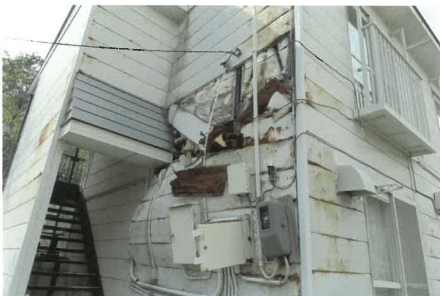
物件10:南東角外壁の状況
