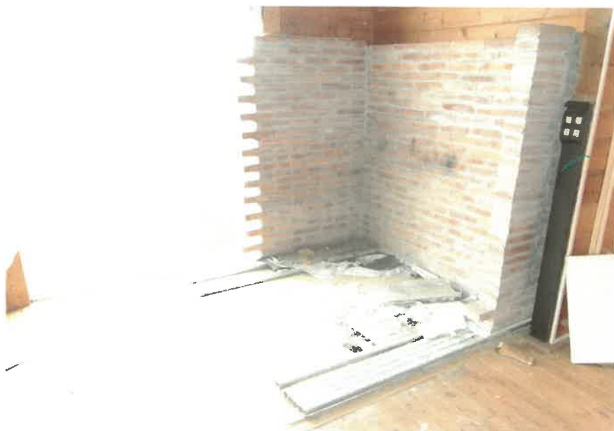
物件3主である建物:事務室(東側から順に1番)の状況
