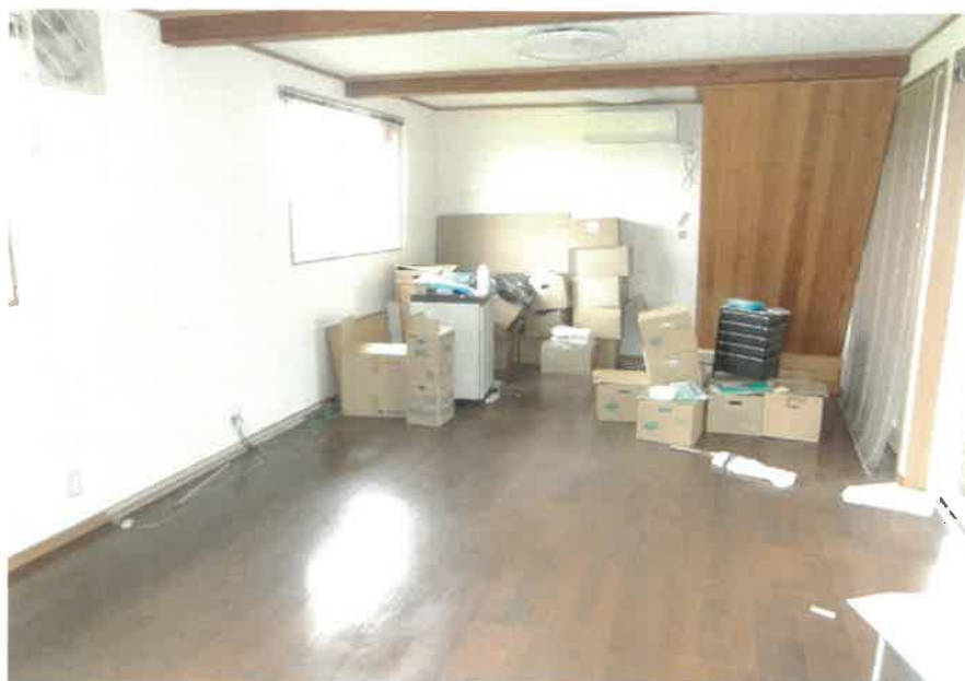
物件3附属建物符号1:1階洋室の状況
