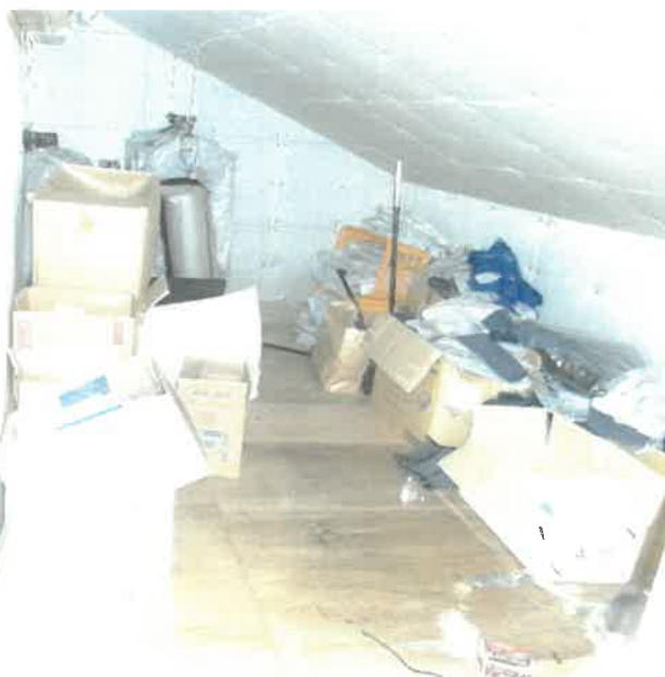
物件3附属建物符号1:2階洋室の状況
