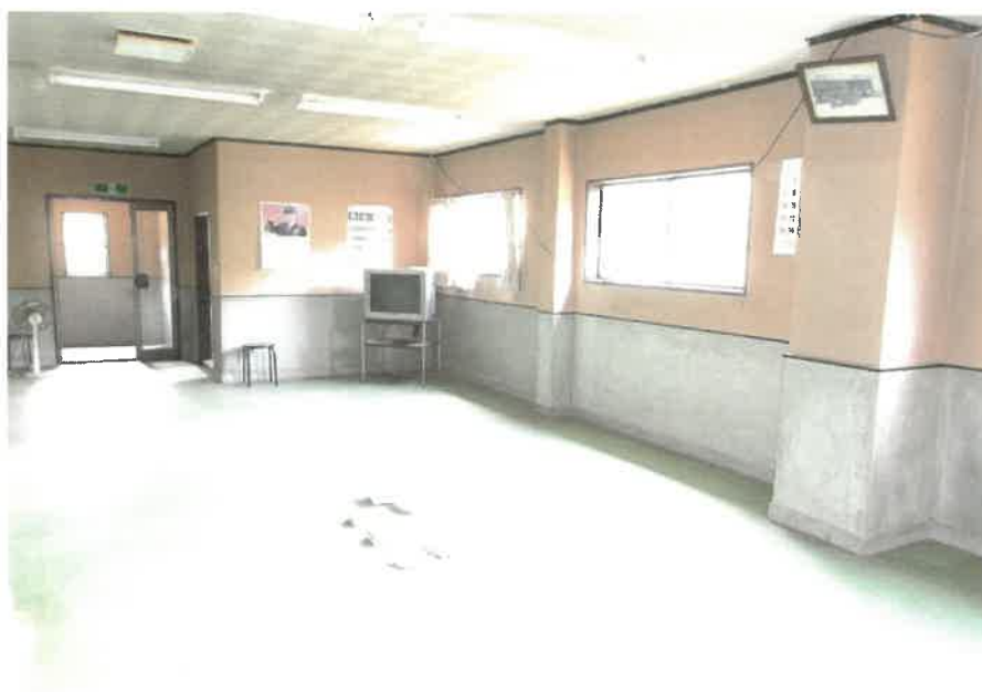
物件1:2階事務室の状況
