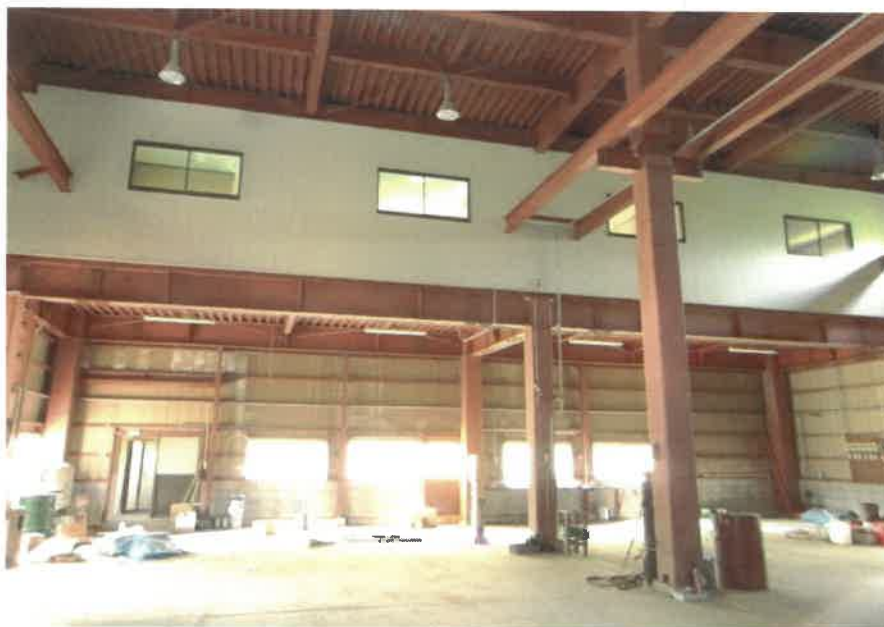
物件1:1階作業場の状況
