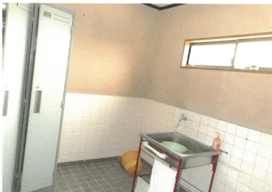
物件1:1階トイレの状況
