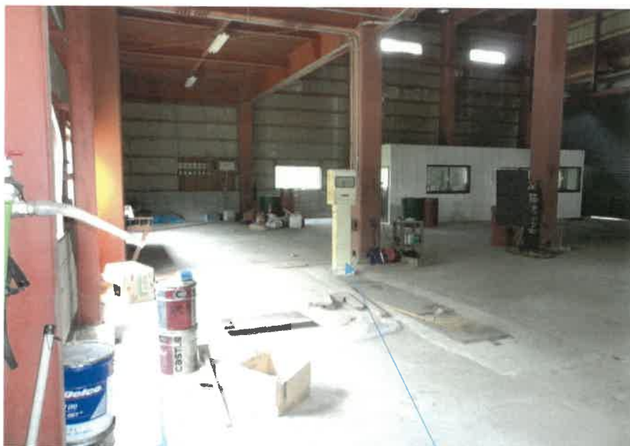
物件1:1階作業場の状況
