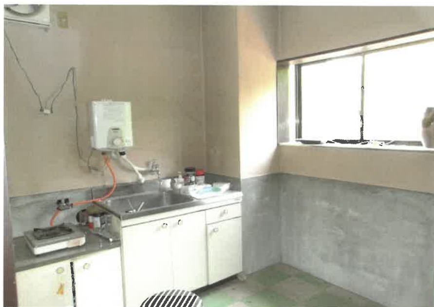
物件1:2階湯沸室の状況
