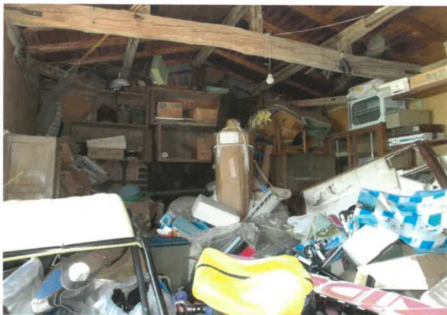
物件2附属建物符号1:2階の状況
