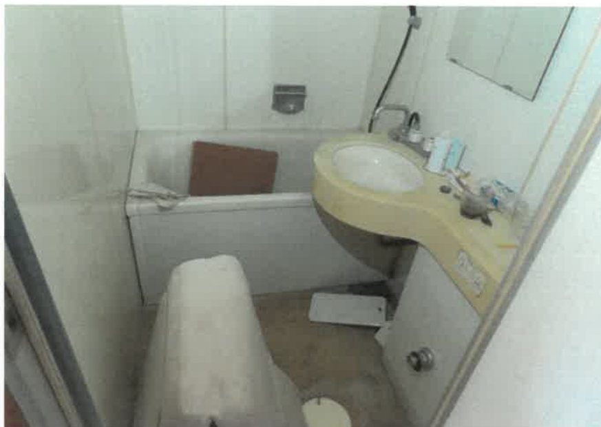
物件4:2階和室(20)のユニットバスの状況
