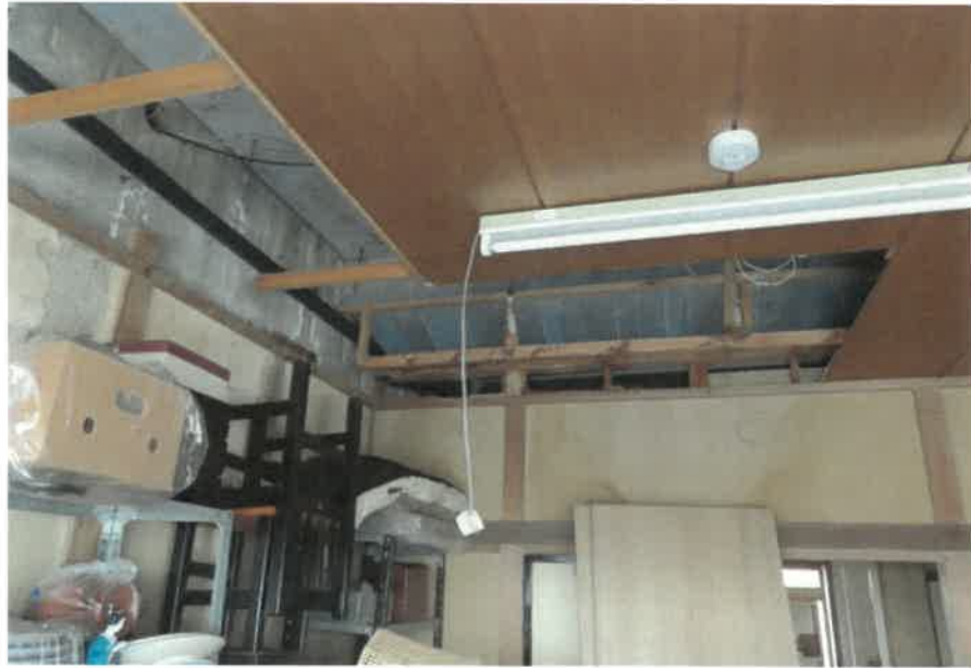
物件4:2階和室(22)の状況
