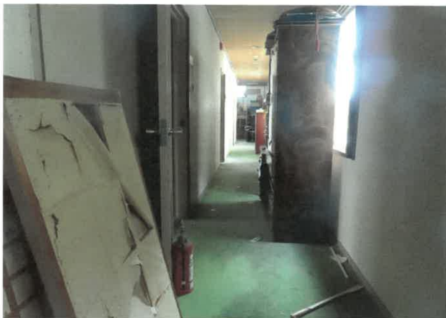
物件4:2階各和室前廊下の状況
