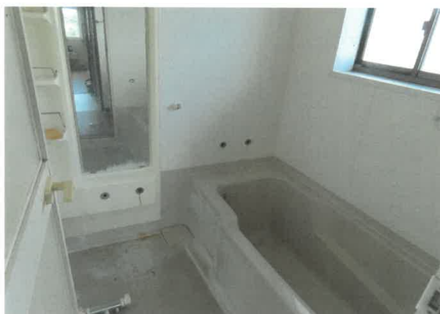
物件4:3階浴室の状況
