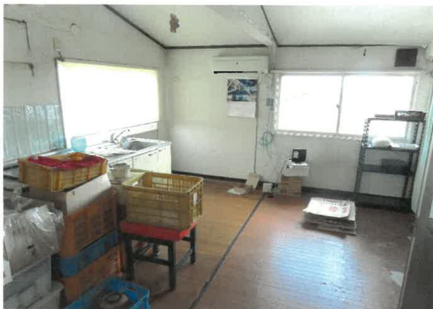
物件4:3階台所の状況
