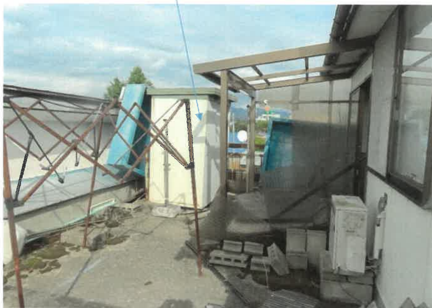
物件4:屋上の状況
