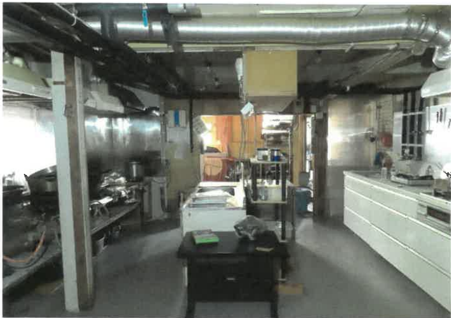
物件3:1階厨房の状況
