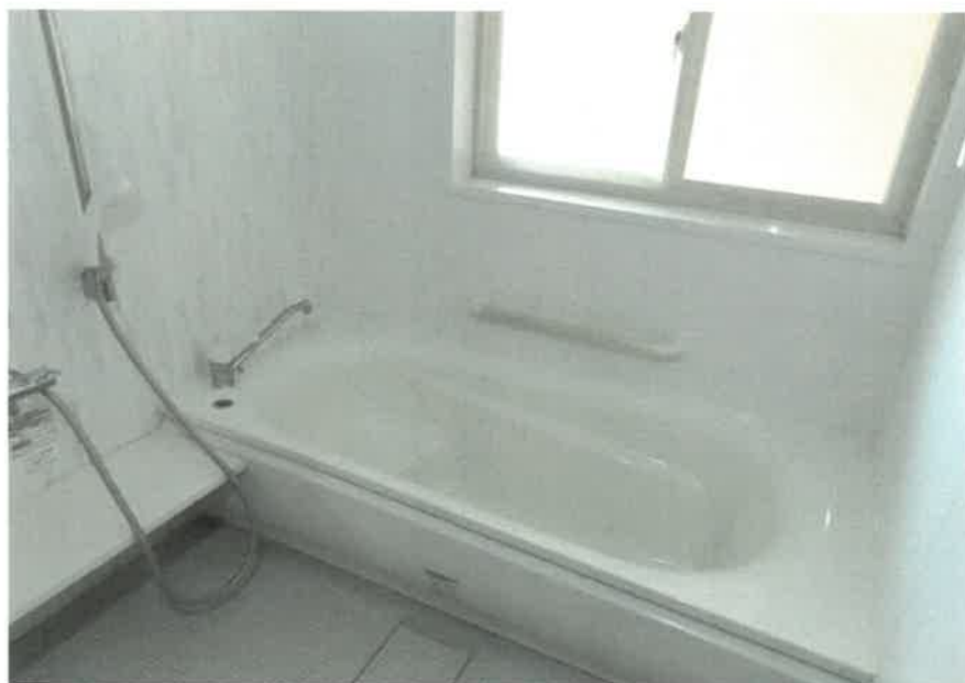
物件3:浴室(北側)の状況
