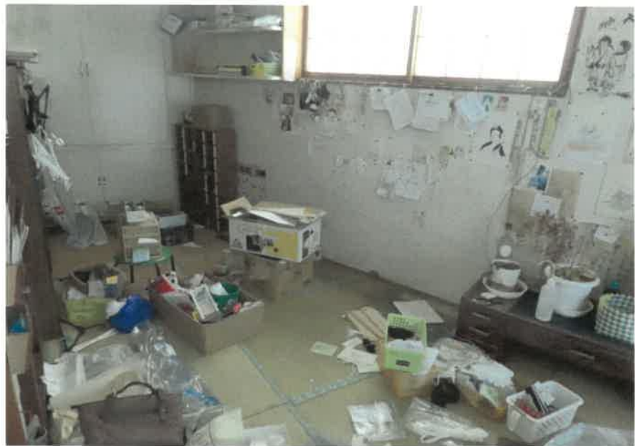
物件3:1階和室の状況
