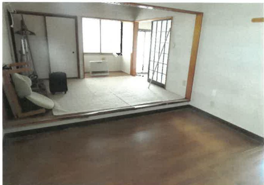
物件4:3階洋室(2室)の状況
