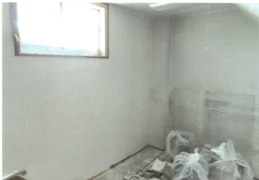
物件4:1階作業場の状況
