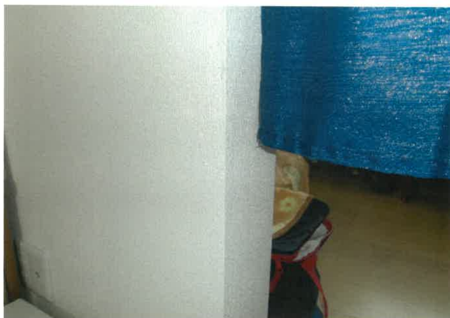
物件4:2階南東側洋室の北側壁部分の状況
