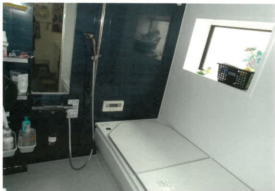
物件4:1階浴室の状況
