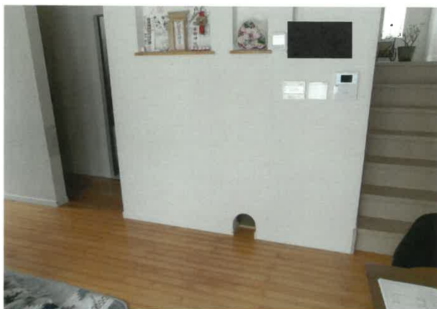
物件4:1階物入の下部部分の状況
