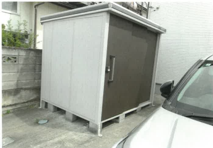
物件1の北西側の簡易物置(動産)の状況
