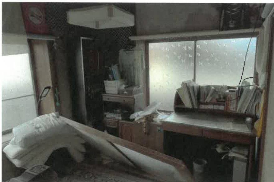
物件2:1階北東側和室の状況
