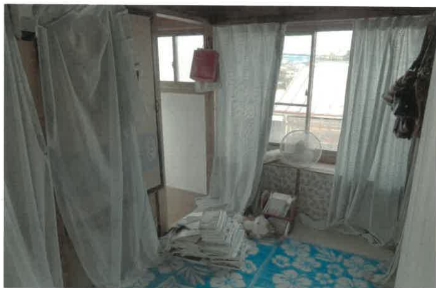
物件2:2階西側和室の状況
