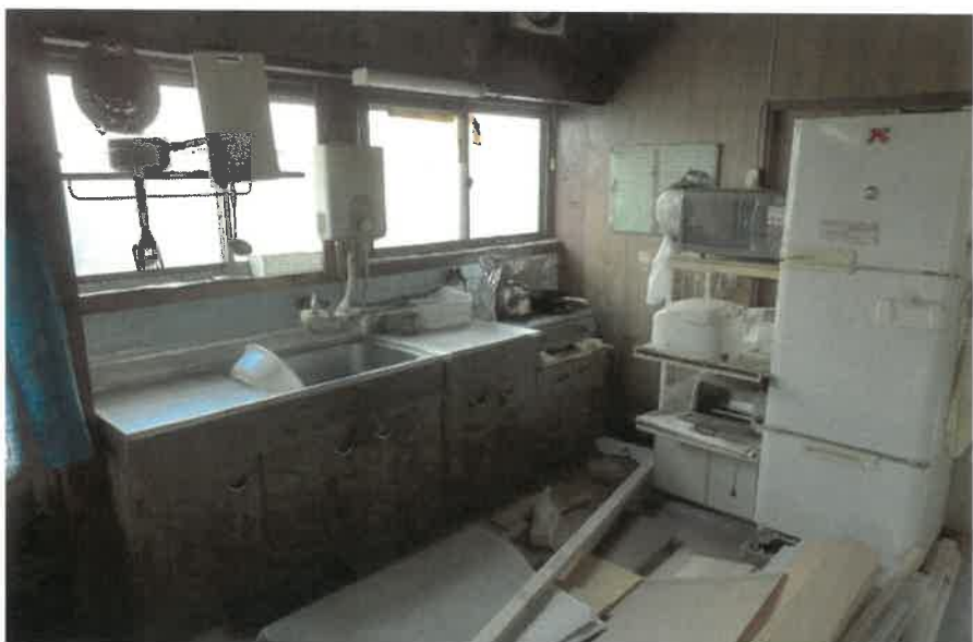
物件2:1階台所の状況
