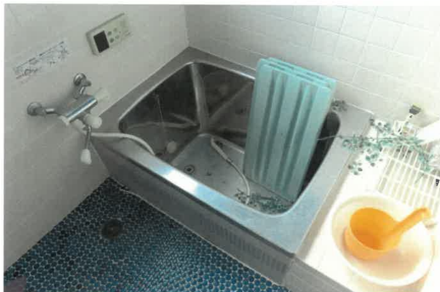
物件2:1階浴室の状況
