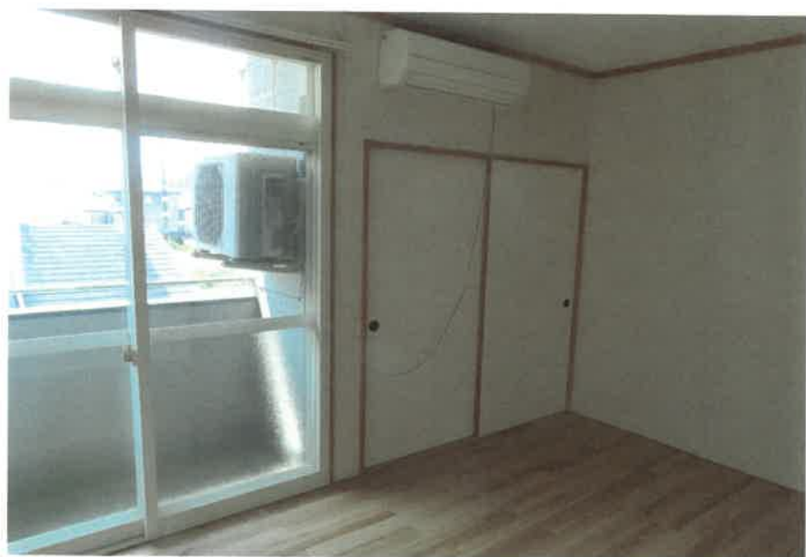
物件2:201南側洋室の状況
