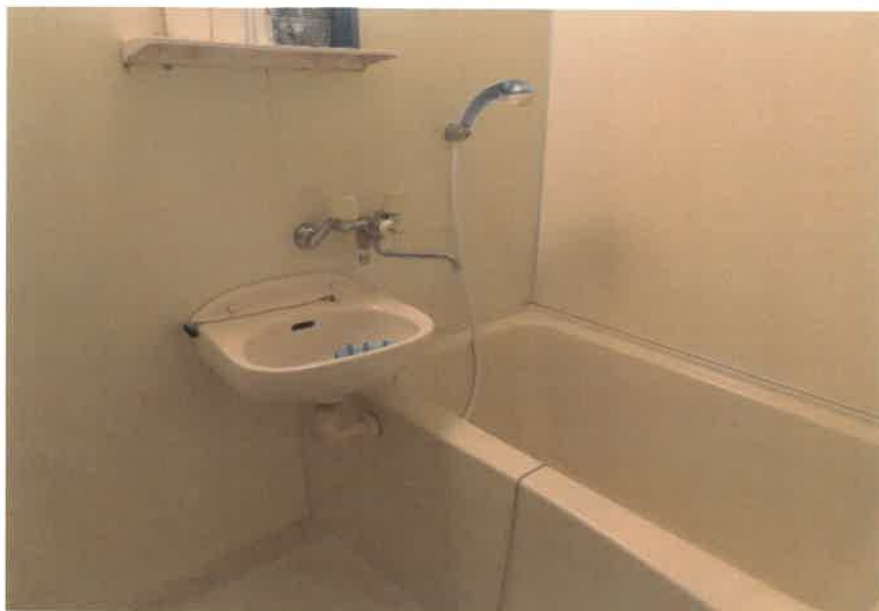
物件2: 202浴室の状況
