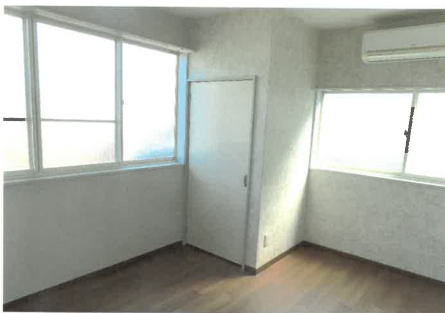
物件2:103北側洋室の状況
