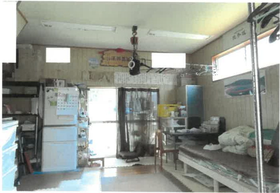
物件3:1階洋室の状況
