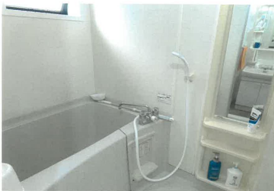
物件4:101浴室の状況
