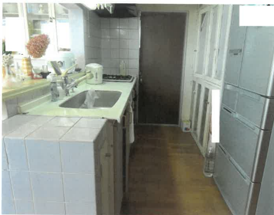
物件7主である建物:2階台所の状況
