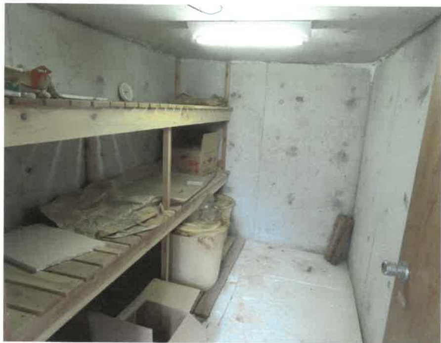
物件7未登記附属建物:地下1階倉庫の状況
