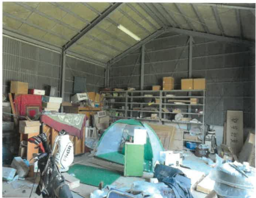
物件4主である建物の内部の状況
