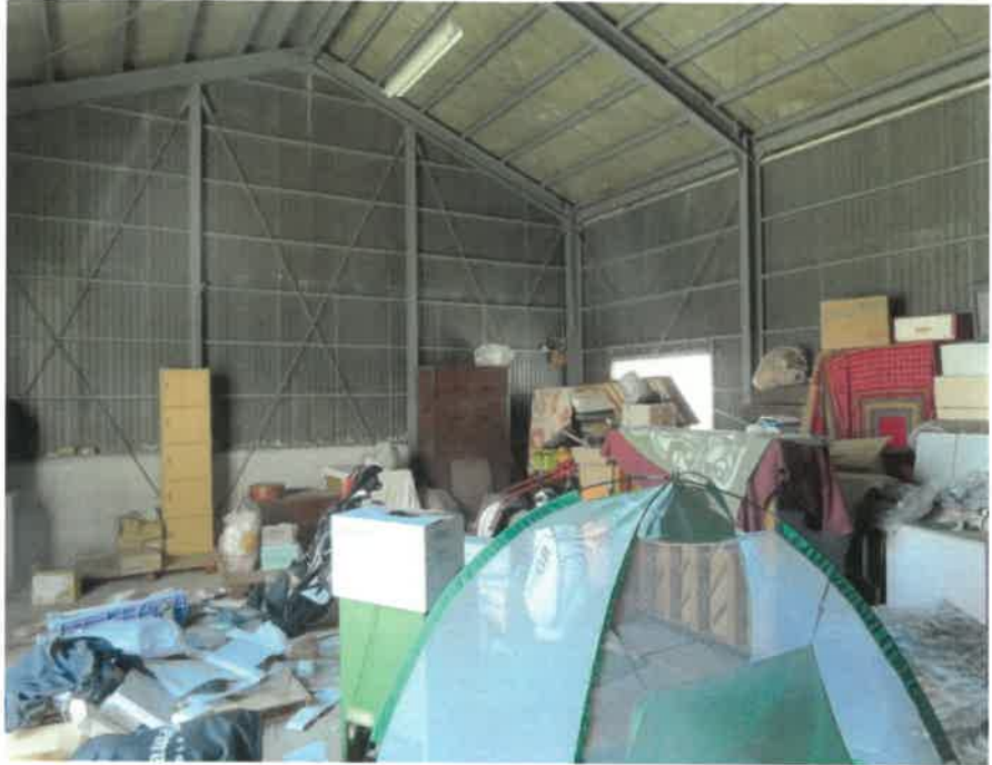
物件4主である建物の内部の状況
