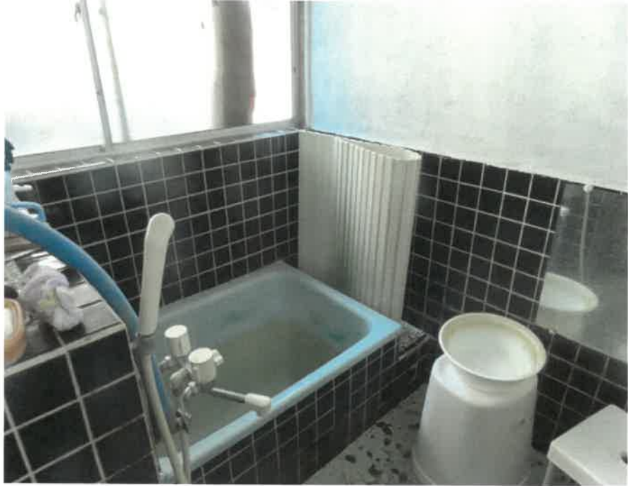
物件2主である建物:1階浴室の状況
