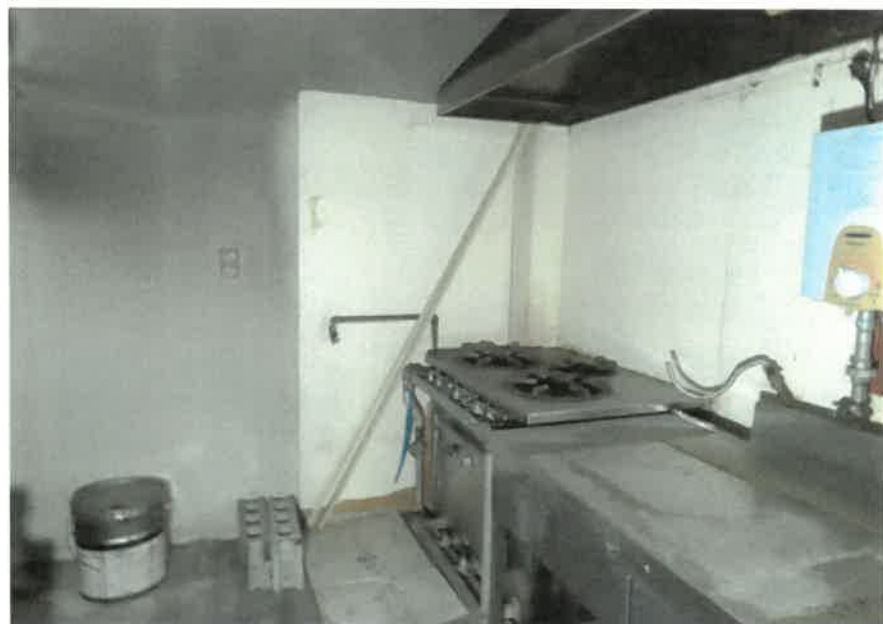
物件2:2階店舗(厨房)の状況
