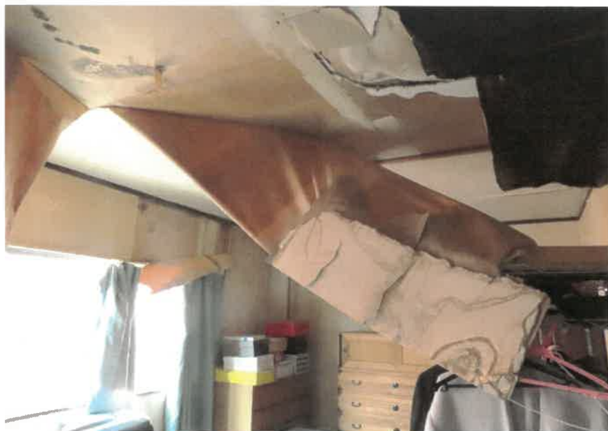
物件2:3階洋室の状況
