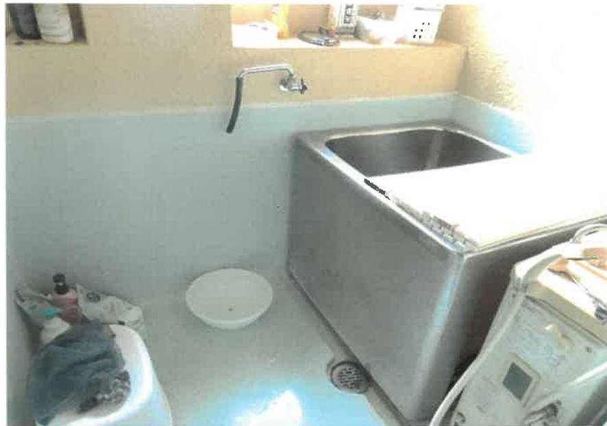
物件2:3階浴室の状況
