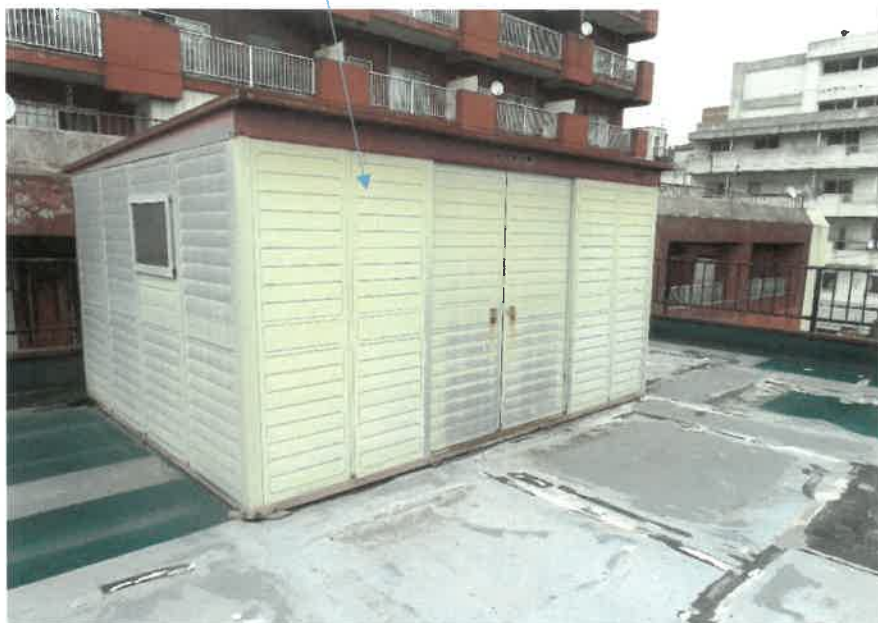
物件2:屋上の状況
