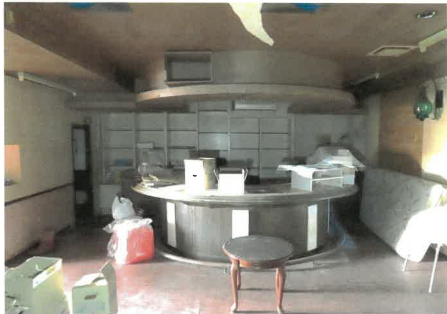
物件2:2階店舗の状況
