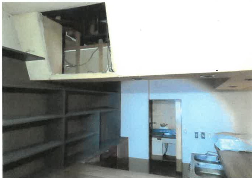
物件2:1階東側店舗の状況
