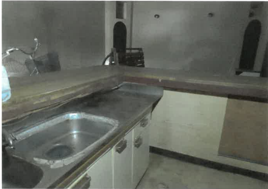
物件2:1階東側店舗の状況
