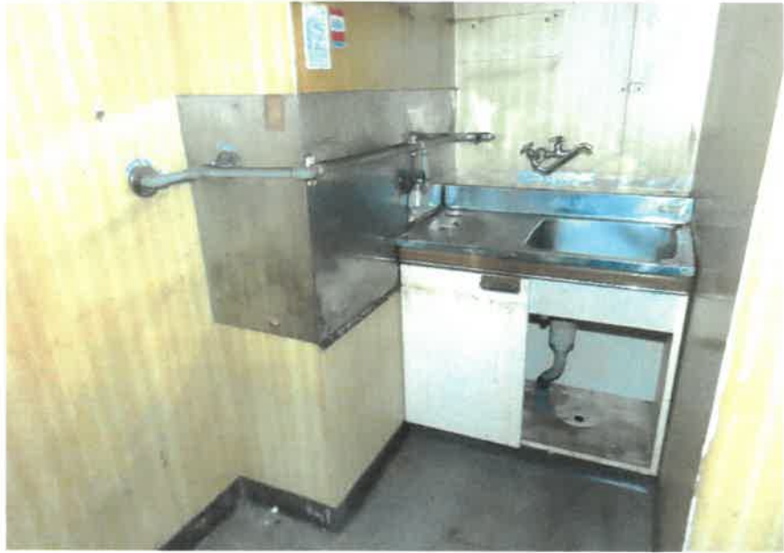
物件2:1階東側店舗(厨房)の状況
