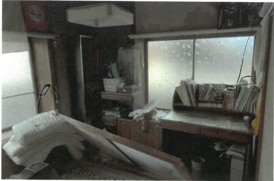
物件2:1階北東側和室の状況
