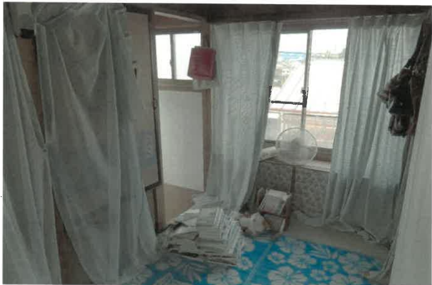
物件2:2階西側和室の状況
