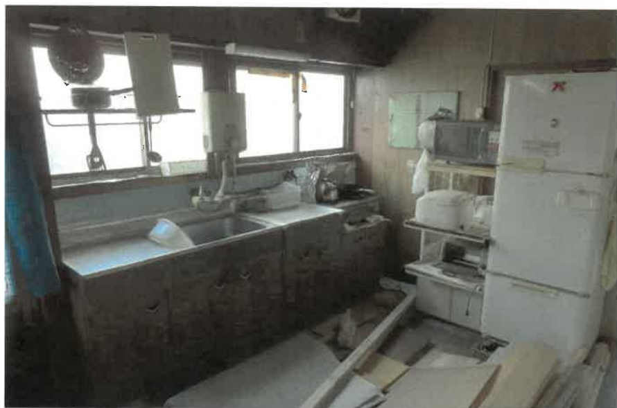
物件2:1階台所の状況
