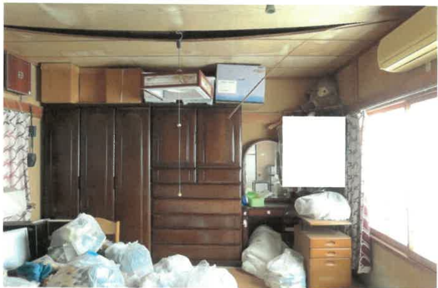
物件2:2階東側和室の状況
