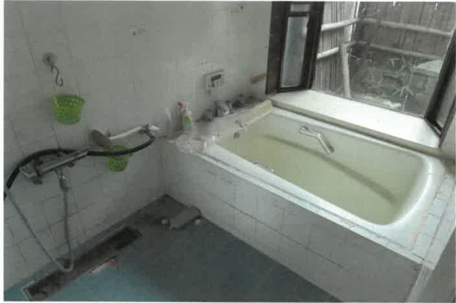
物件3:1階浴室の状況
