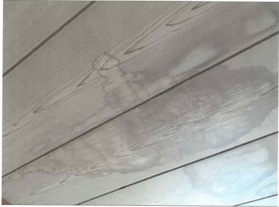
物件3:2階南西側和室の天井雨漏りの状況
