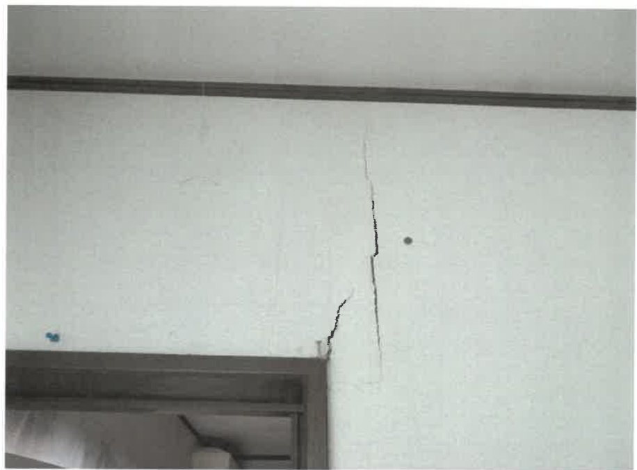
物件3:2階南東側洋室の壁の亀裂
