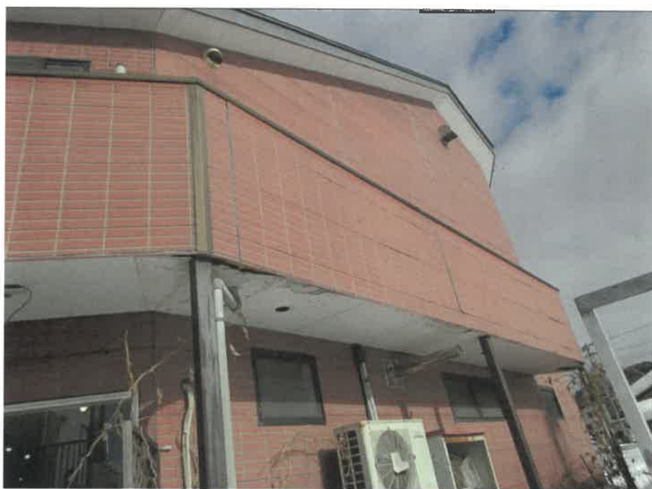
物件3:2階ベランダ部分の外壁タイルの浮き、軒下の損傷
