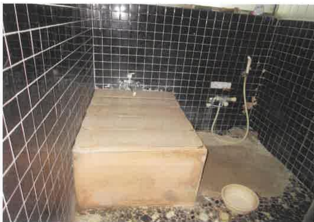
物件2主である建物の浴室の状況
