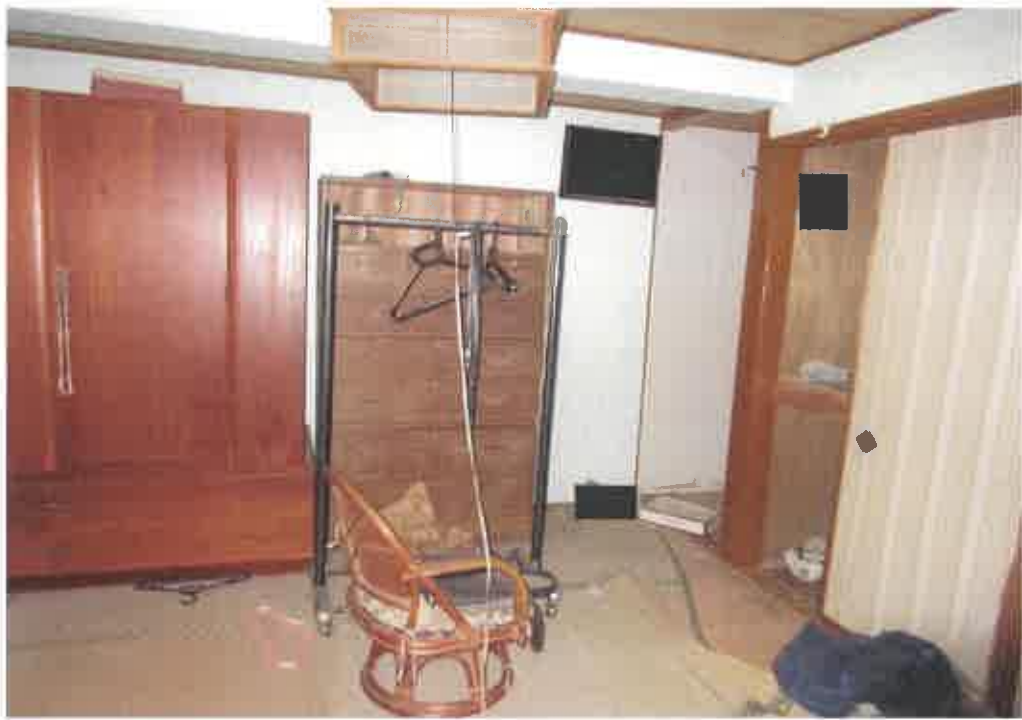
物件2未登記附属建物1の和室の状況
