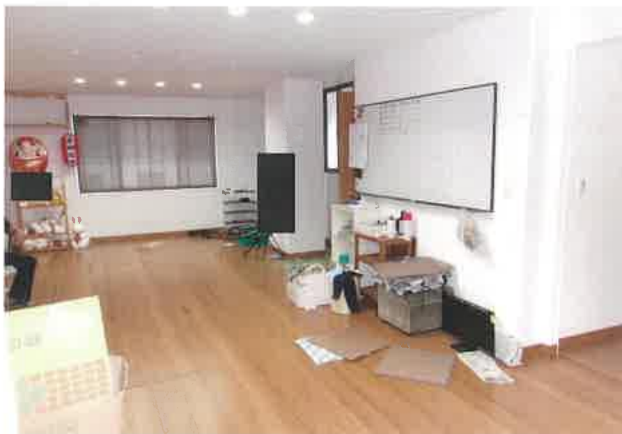
物件2:1階北西側洋室の状況
