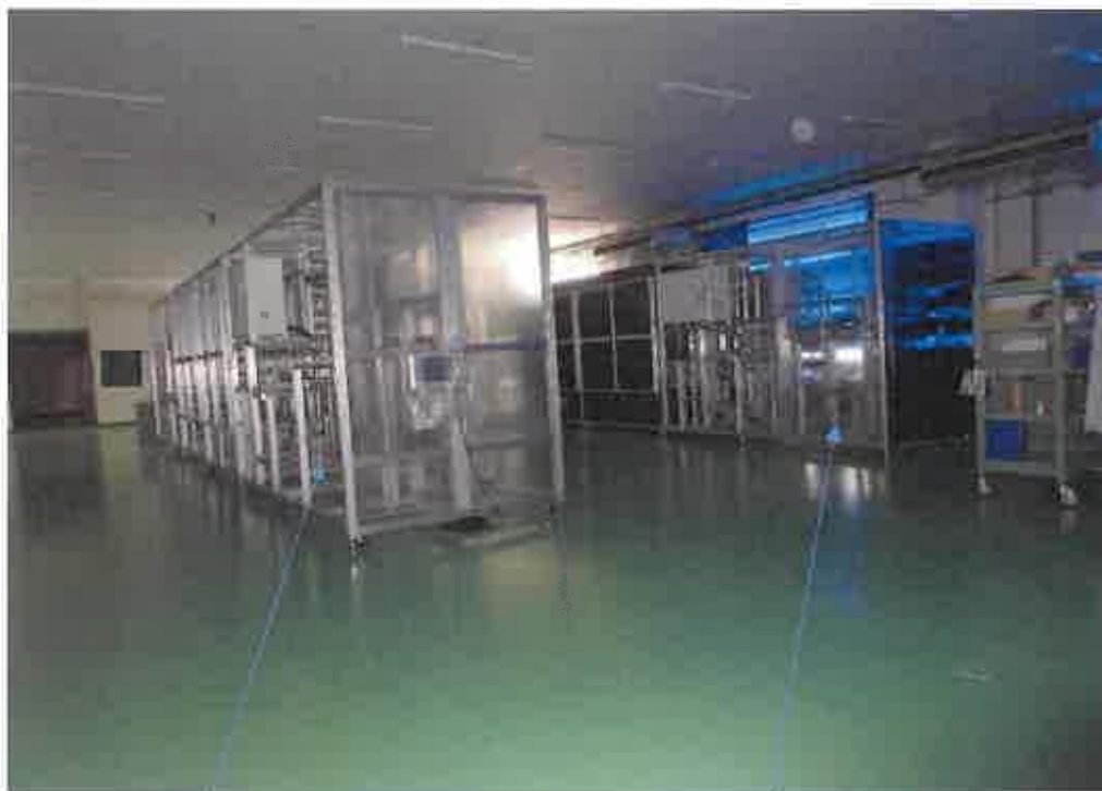
制作途中の機械(目的外動産)
