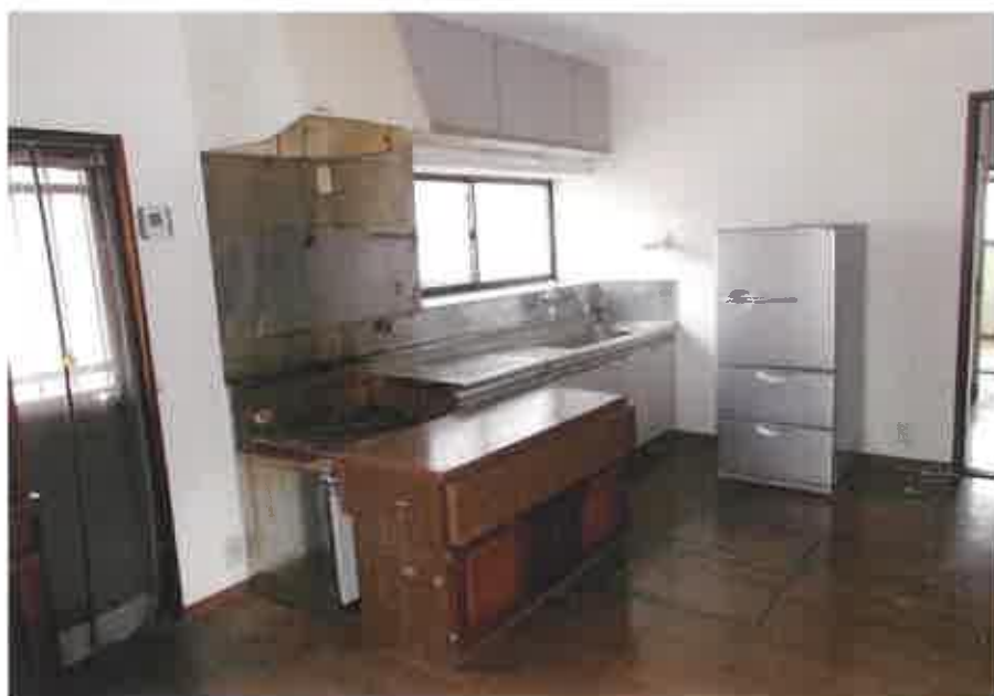
物件3:1階台所の状況
