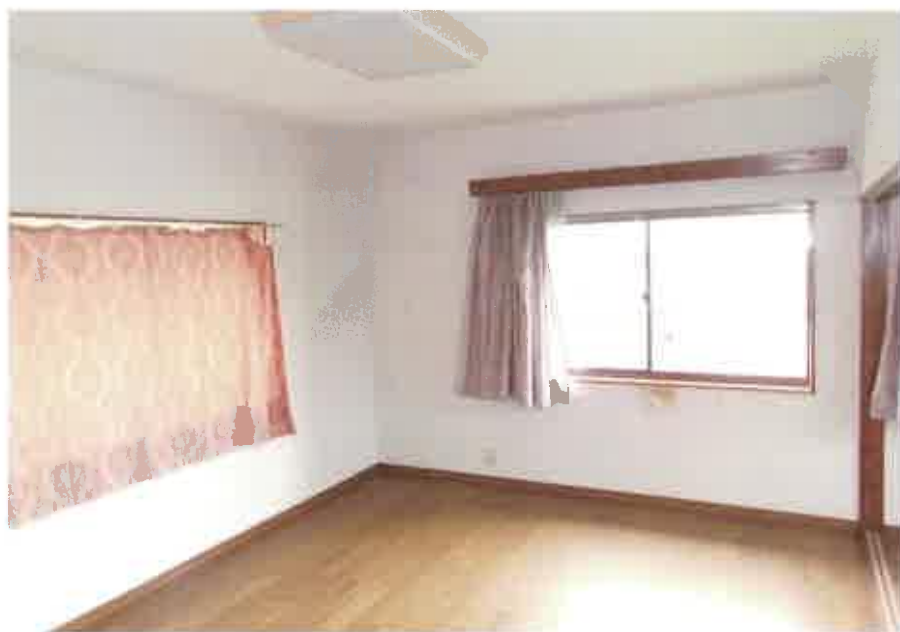
物件3:2階東側洋室の状況
