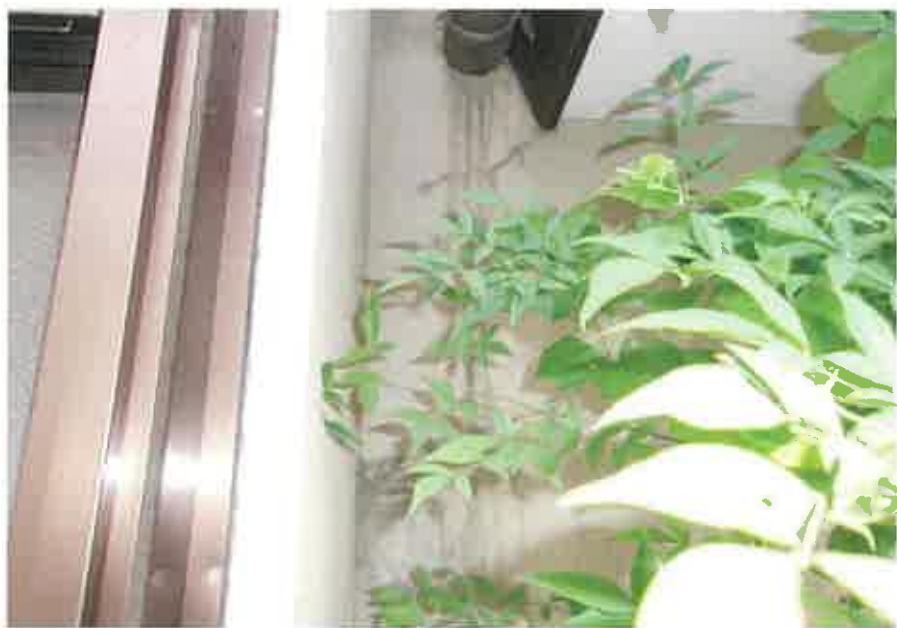
物件3: 1階玄関外側雨樋付近の状況
