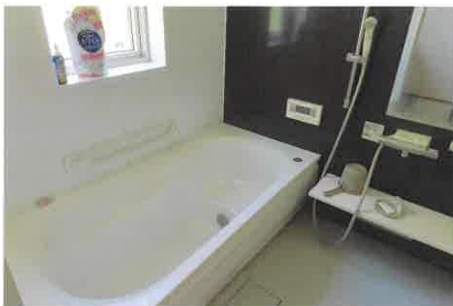
物件2:1階浴室の状況
