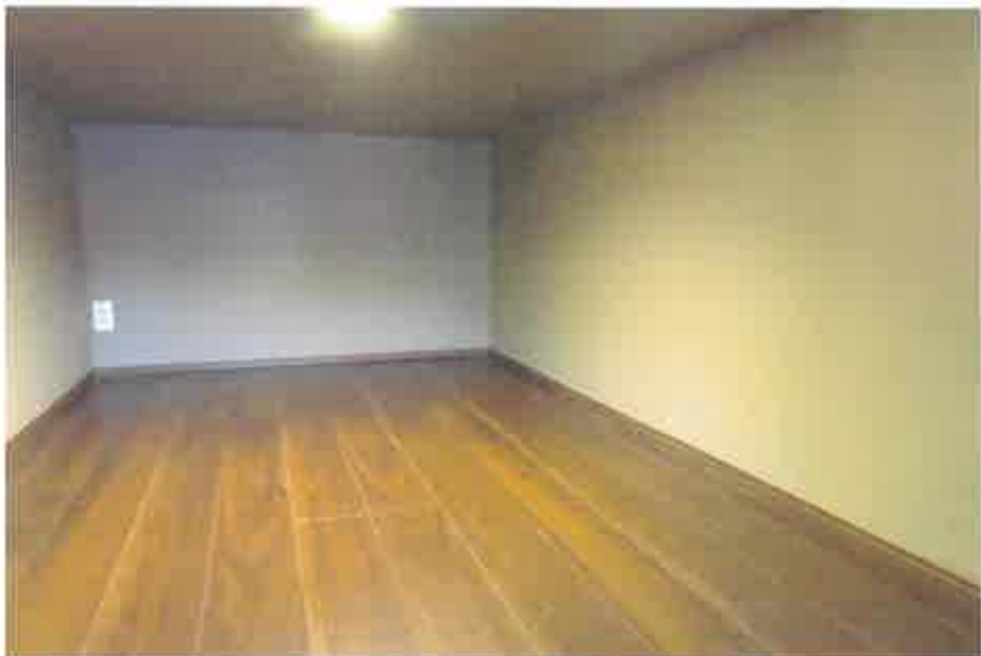
物件2:2階屋根裏の状況
