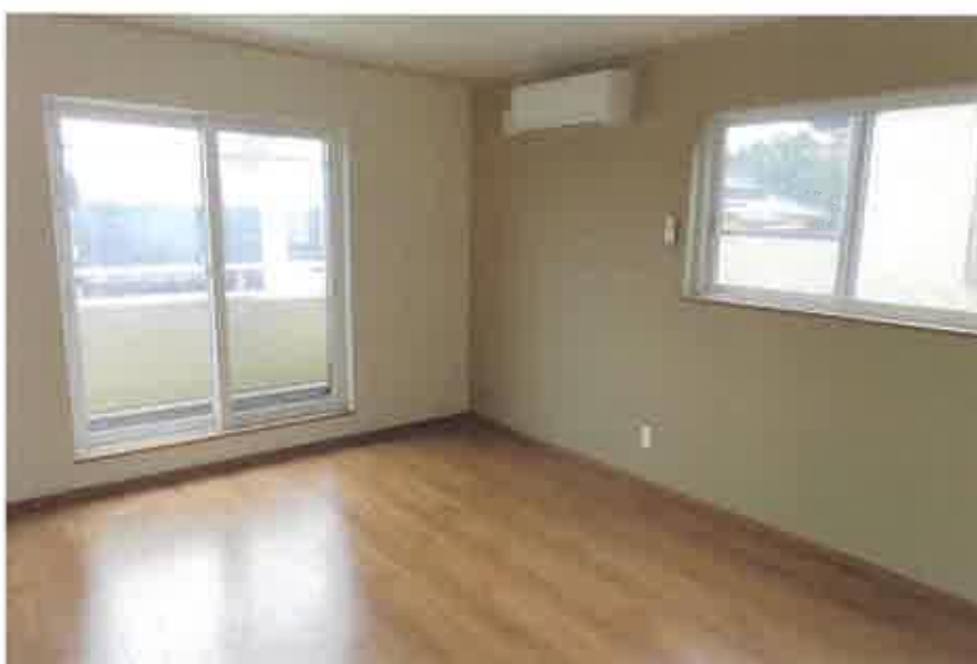
物件2:2階西側洋室の状況
