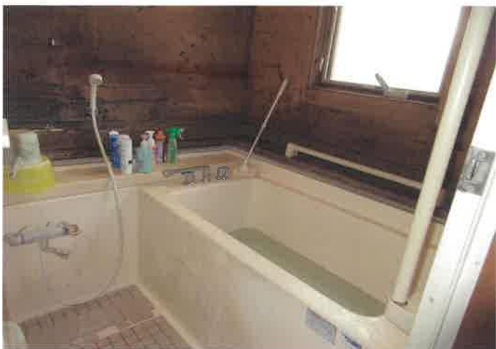
物件3:1階浴室の状況
