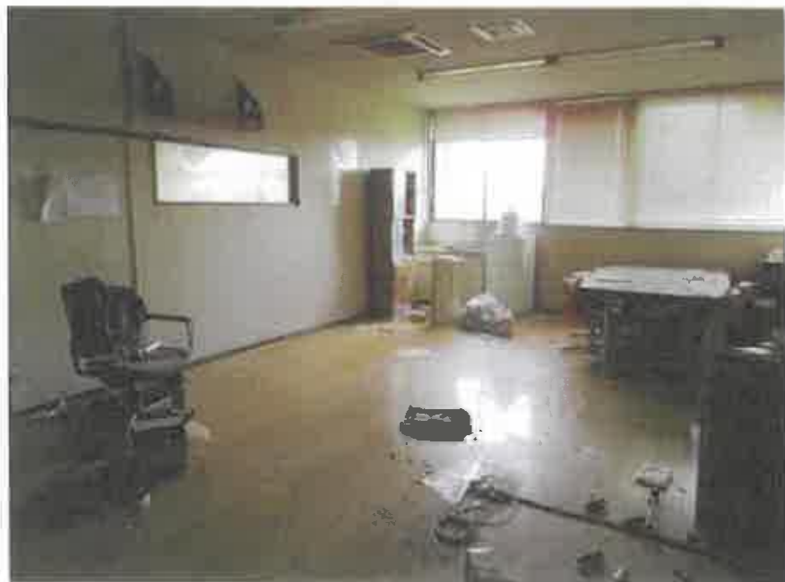
No. 12 物件4:主である建物1階事務室の状況
