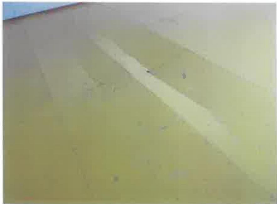
物件4:附属建物符号2東側倉庫の床が沈んでいる状況
