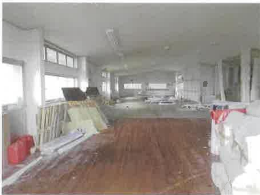
No. 15 物件4:主である建物1階東側工場の状況
