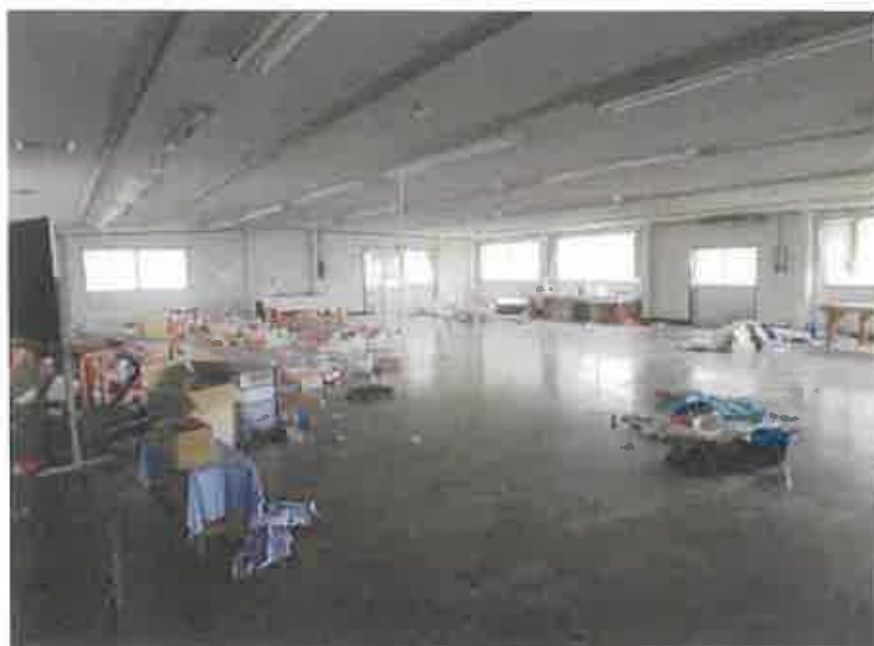
物件4:主である建物1階西側工場の状況
