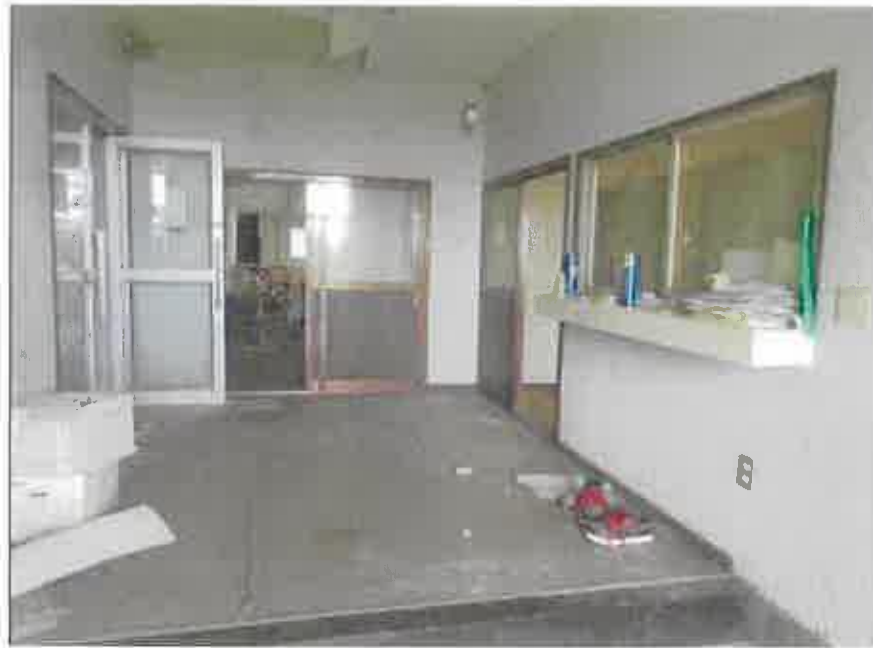
No. 11 物件4:主である建物1階玄関の状況
