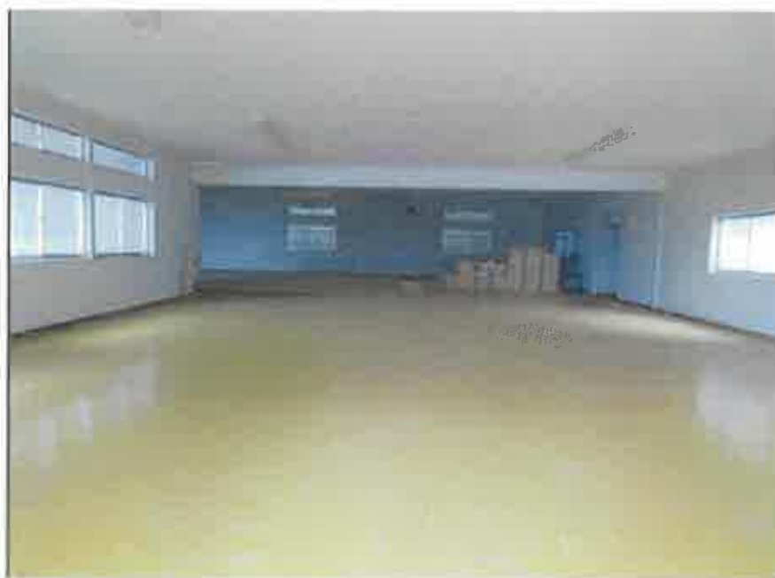
物件4:附属建物符号2東側倉庫の状況
