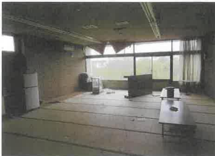
物件4:主である建物1階休憩室の状況
