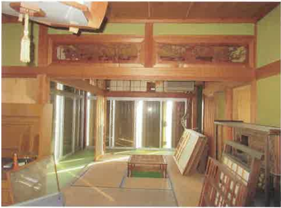
物件3主である建物(別棟):2階和室の状況
