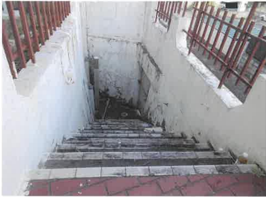
物件1北東側階段の状況
