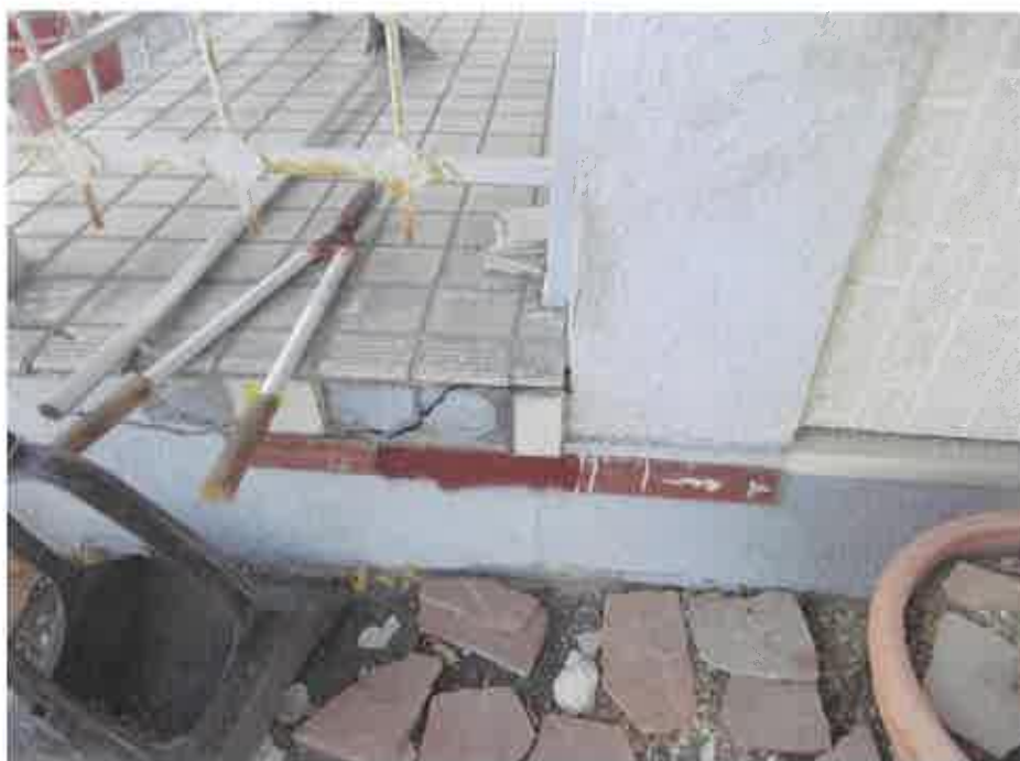
物件3主である建物の基礎部分等の状況
