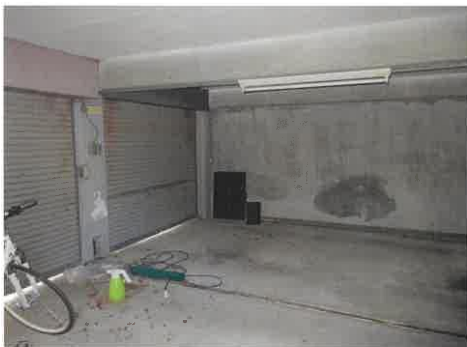
物件3:附属建物符号1の状況
