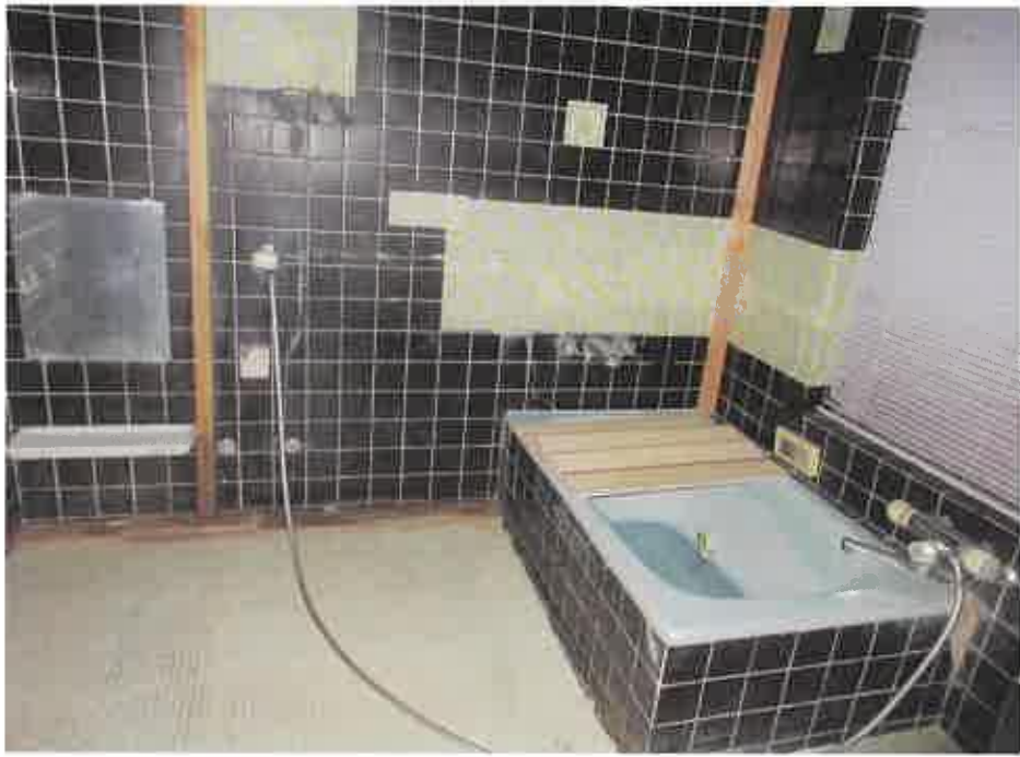
物件3主である建物:1階浴室の状況
