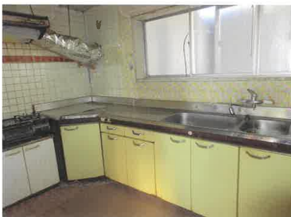
物件3主である建物:1階台所の状況
