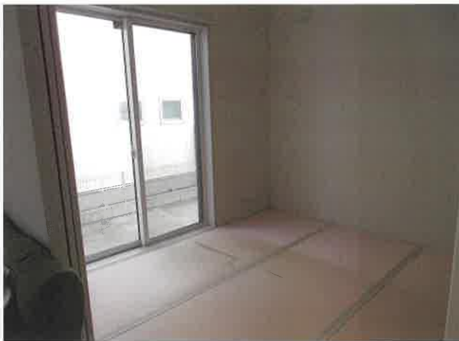
物件2:1階和室の状況
