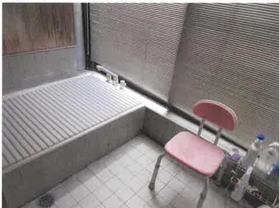
物件2:2階浴室の状況
