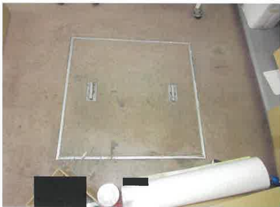
物件2:1階店舗の井戸がある部分の床のハッチ
