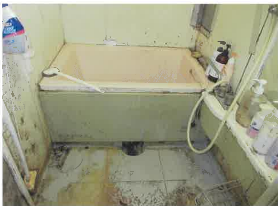
物件2:3階浴室の状況
