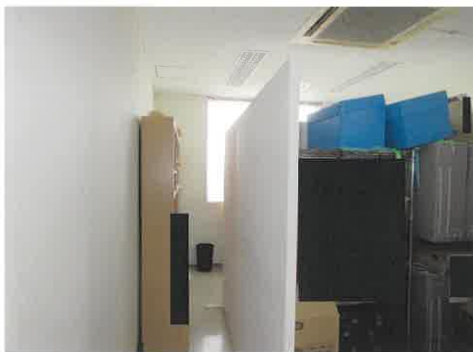
物件3:2階西側事務室の状況
