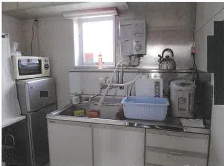
物件3:1階給湯室の状況
