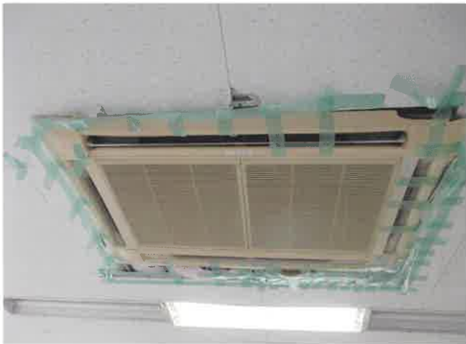
物件3:2階東側事務室の埋め込み式エアコンと天井の状況
