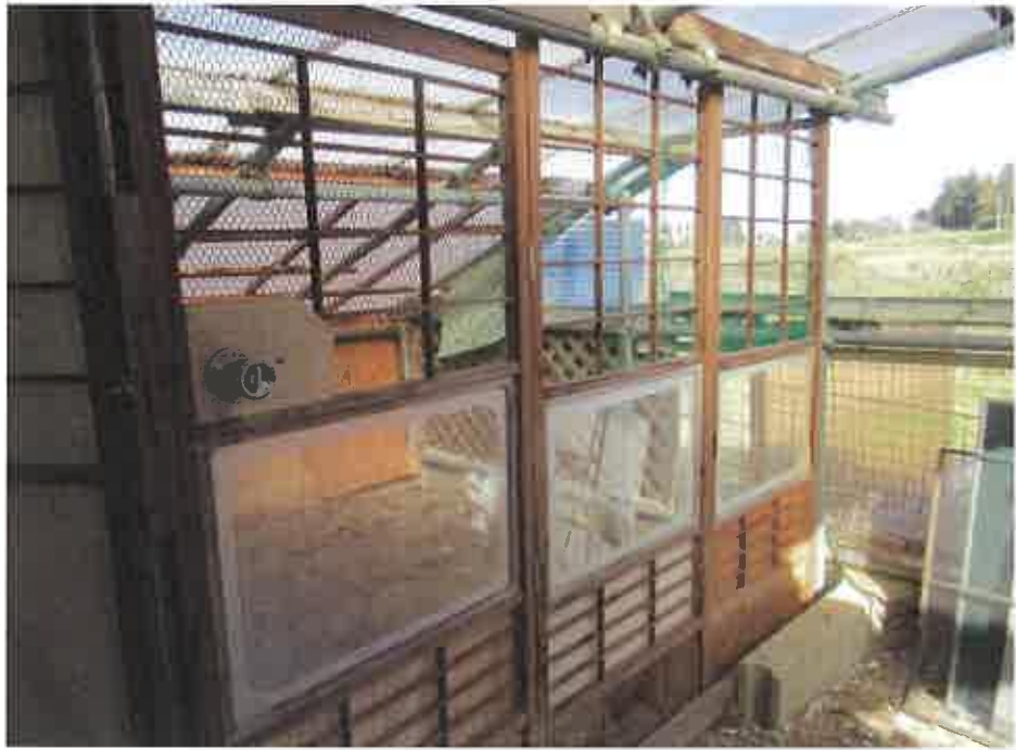
物件2下屋の状況
