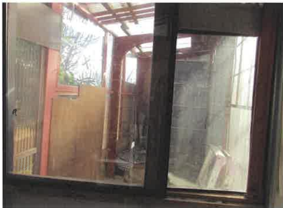
物件2下屋の内部の状況
