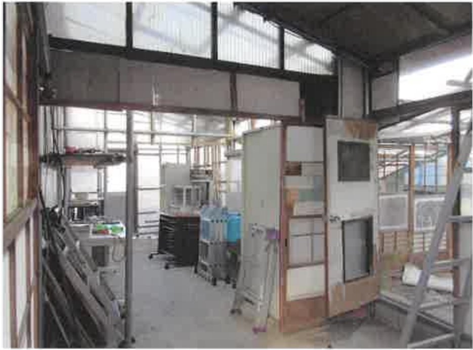
物件2下屋の内部の状況
