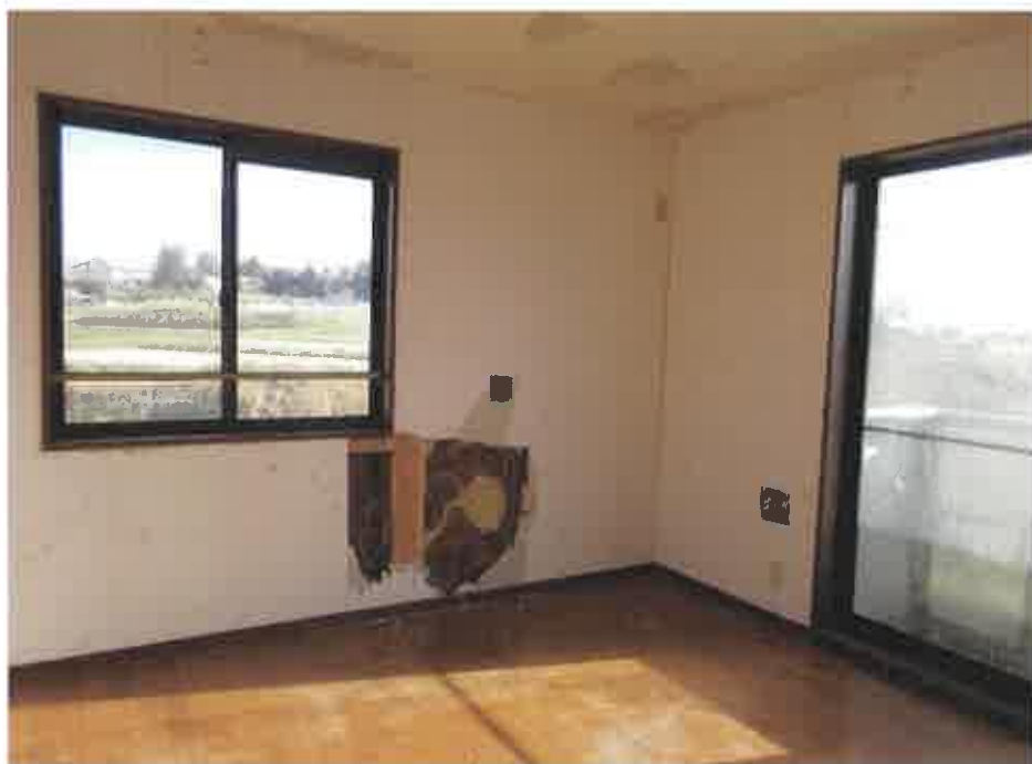
物件2:2階東側洋室の状況
