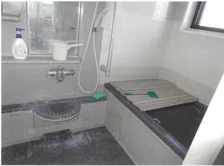
物件2:1階浴室の状況
