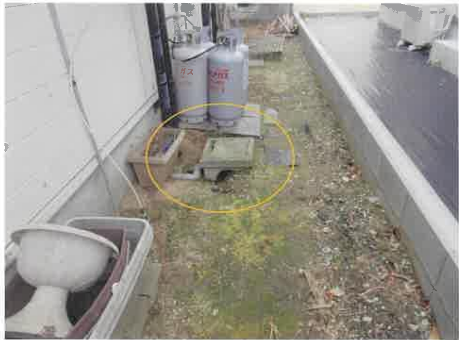
物件2の北側敷地が一部陥没している状況
