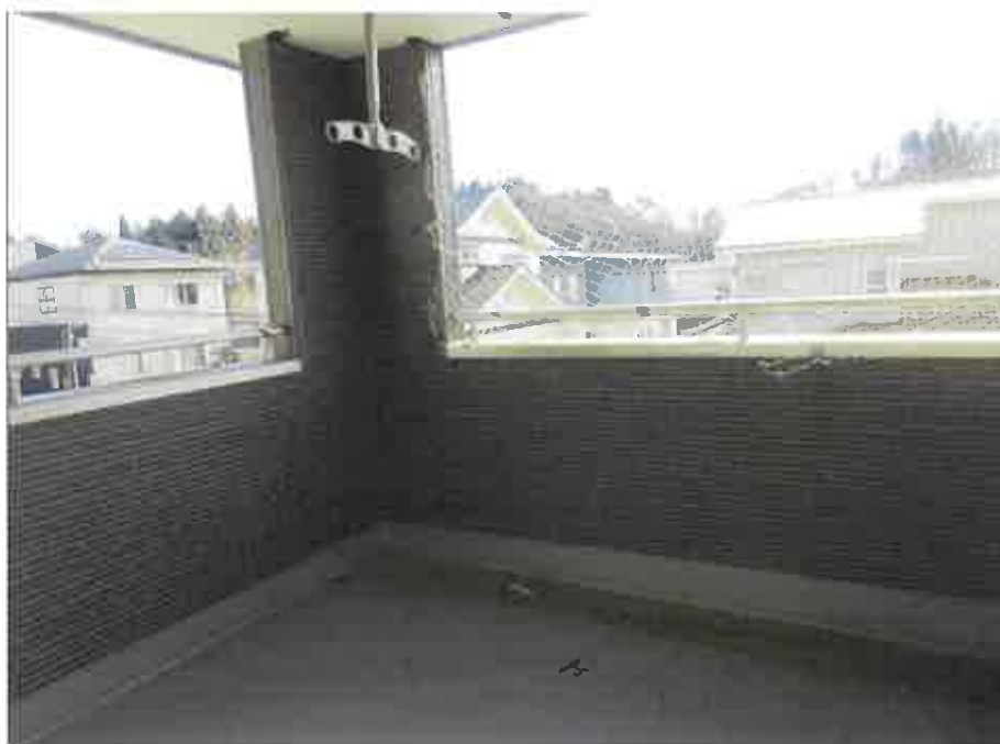
物件2:2階西側バルコニーの状況
