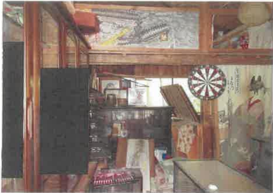
物件2主である建物1階東側増築部分(洋室)の状況 No. 9
