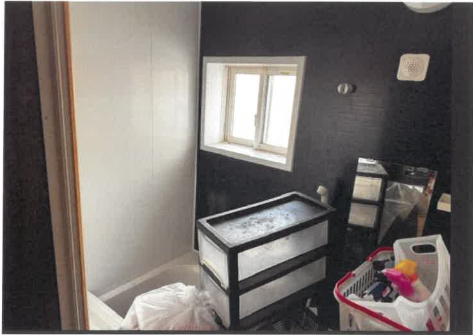
物件1:1階浴室の状況
