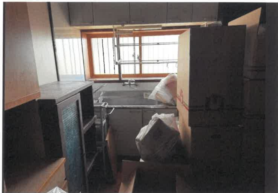
物件1:1階台所の状況
