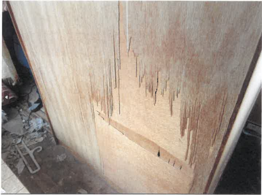
物件3:猫のひっかけ傷で剥げた2階廊下の壁の状況
