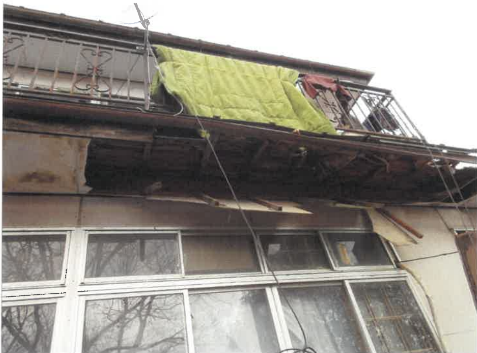
物件3:雨樋と1階屋根軒下の破損状況
