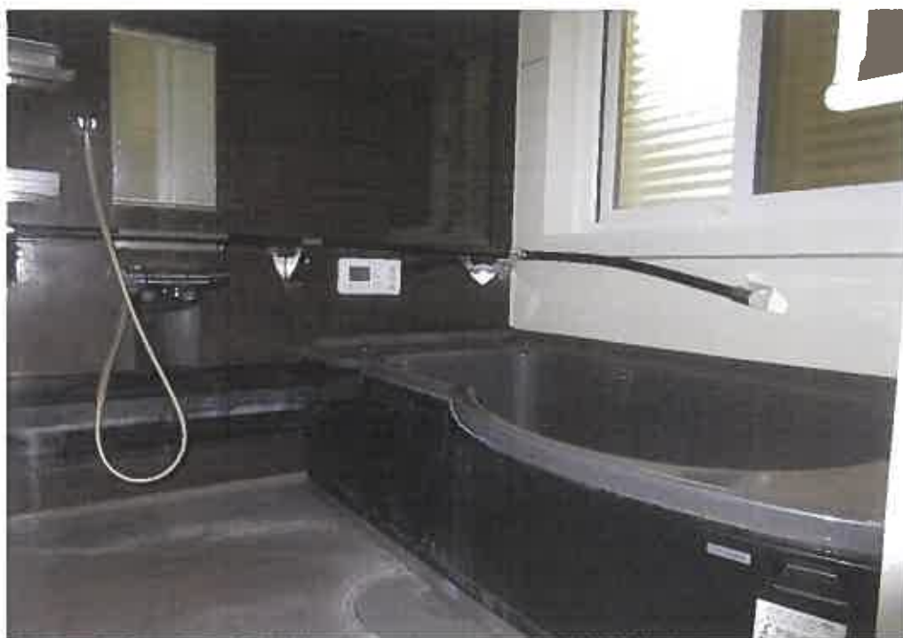
物件3:1階浴室の状況
