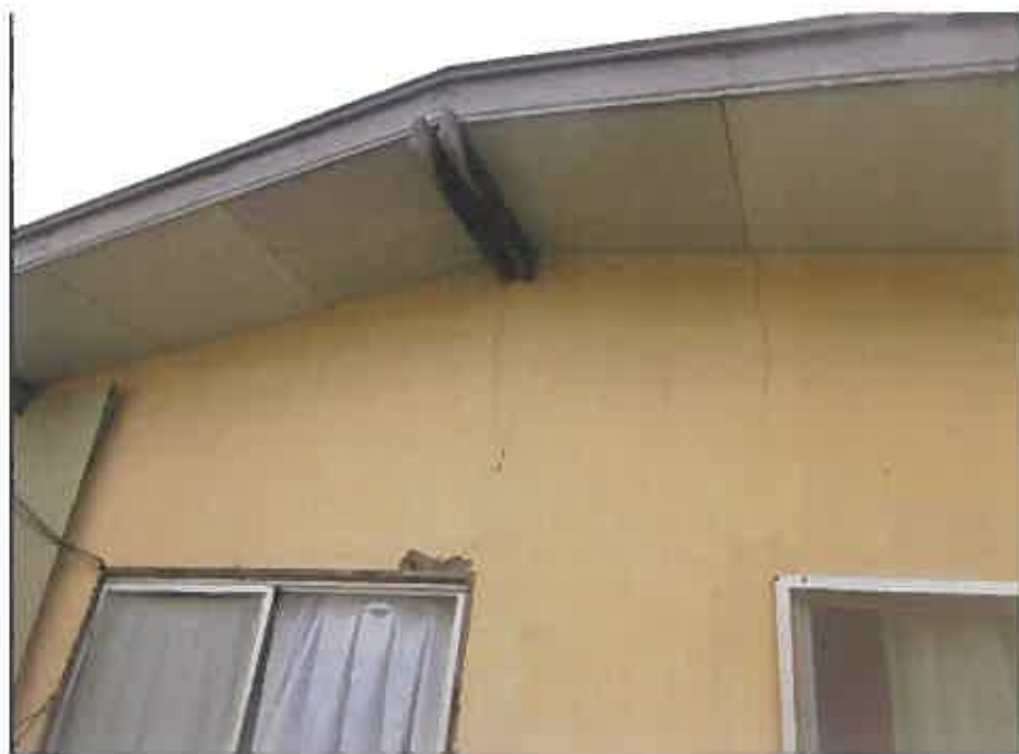
物件2:主である建物の外壁の亀裂
