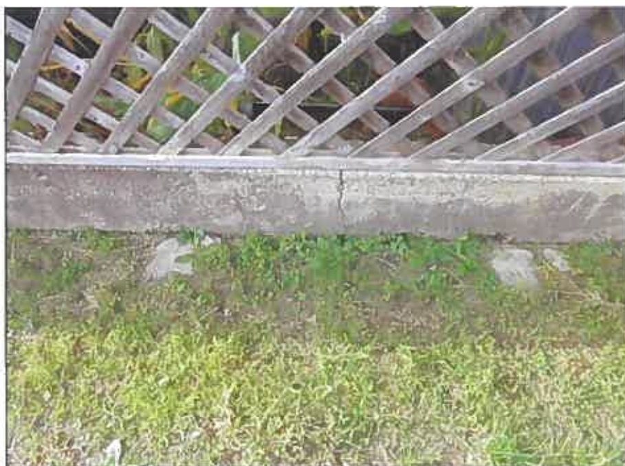
物件1:境界塀の基礎部分の亀裂
