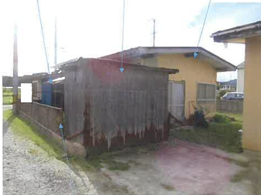
物件2:附属物置符号1 物件2:主である建物増築部分 物件2:主である建物
