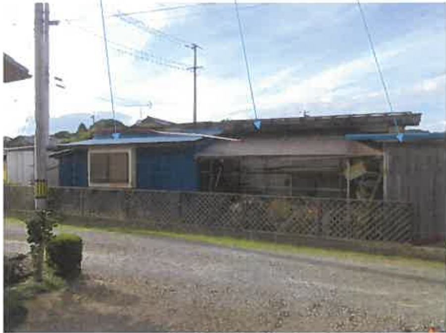
物件2:主である建物 物件2:主である建物増築部分 物件2:附属物置符号1
