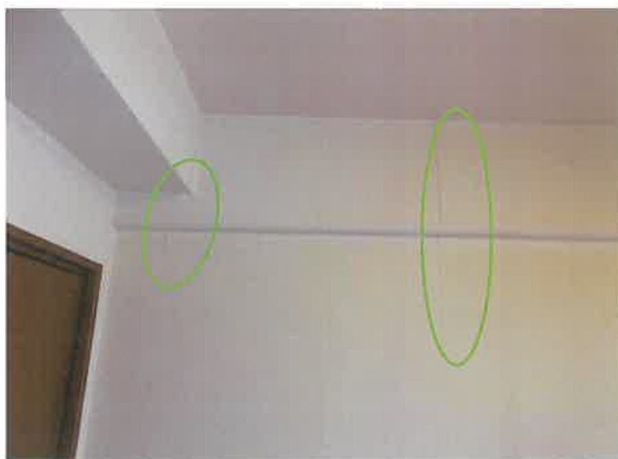
専用部分の建物:壁クロスの剥離した状況
