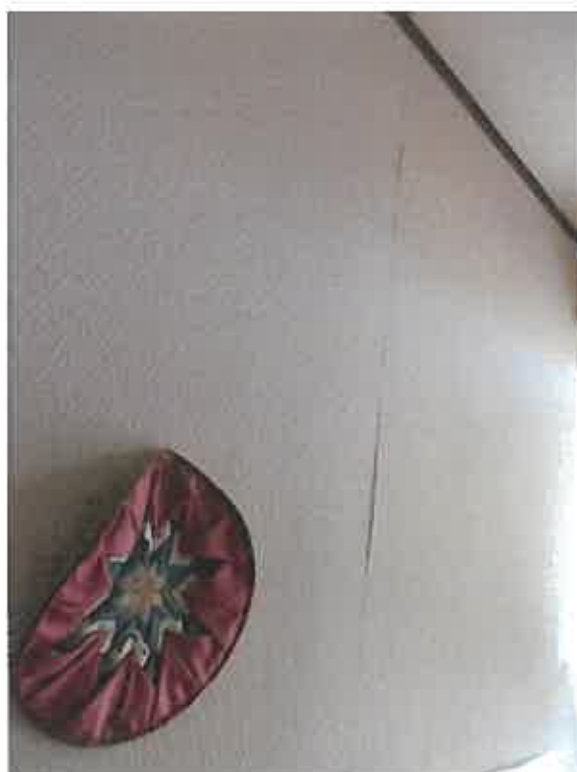
物件3:2階階段の壁クロスの剥離状況
