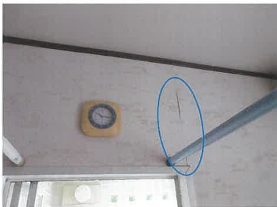
物件3:1階洗面所の壁クロスの剥離状況
