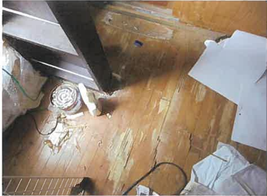
物件2:1階脱衣所の床の擦り切れ状況
