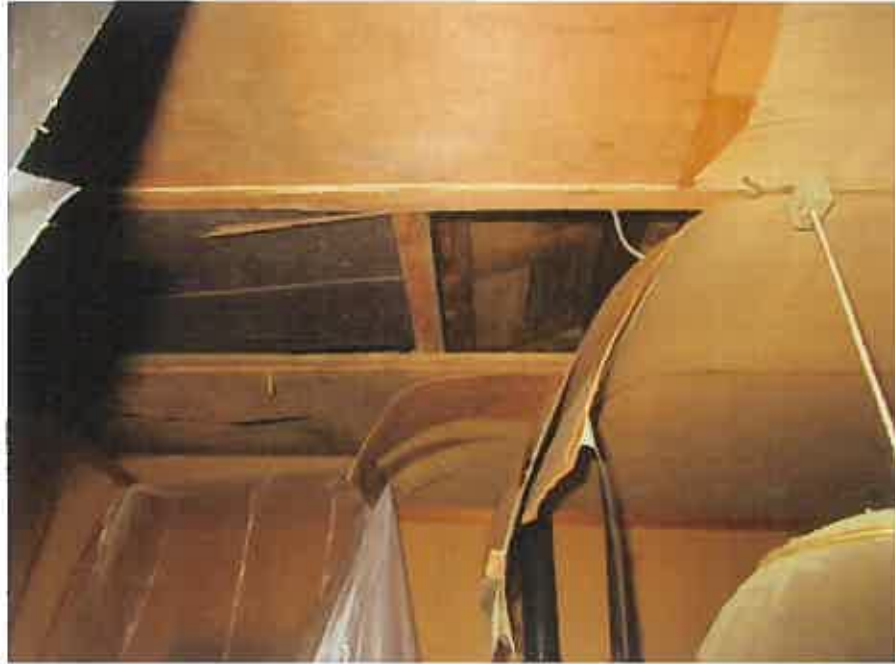
物件2:2階南側和室の雨漏り箇所
