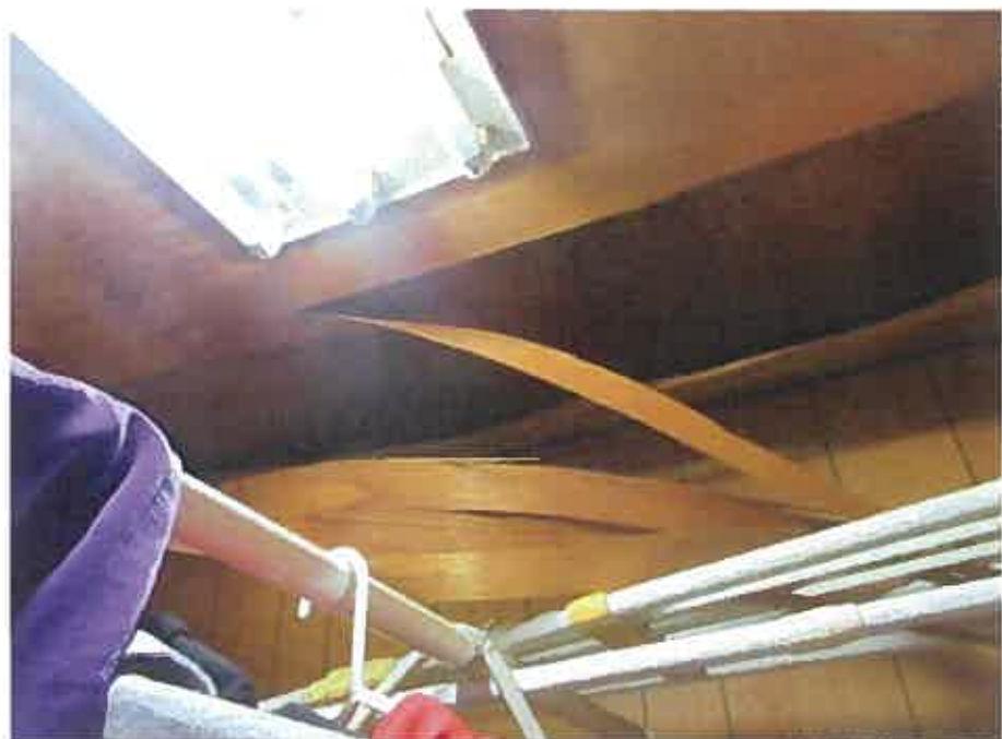
物件2:1階脱衣所の雨漏り箇所
