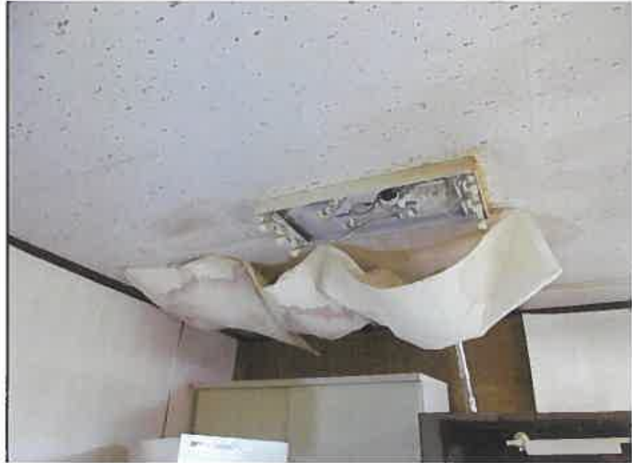
物件2:1階台所天井の雨漏り箇所
