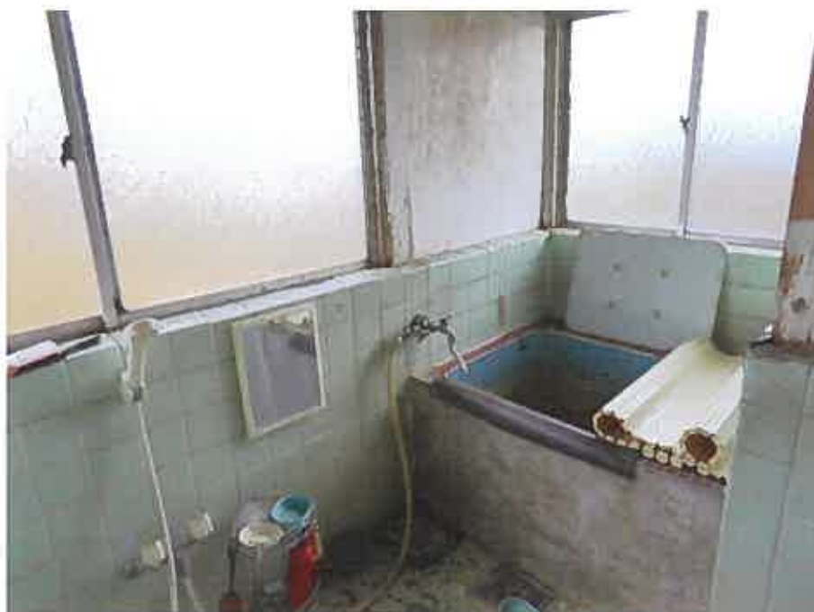
物件12主である建物:浴室の状況
