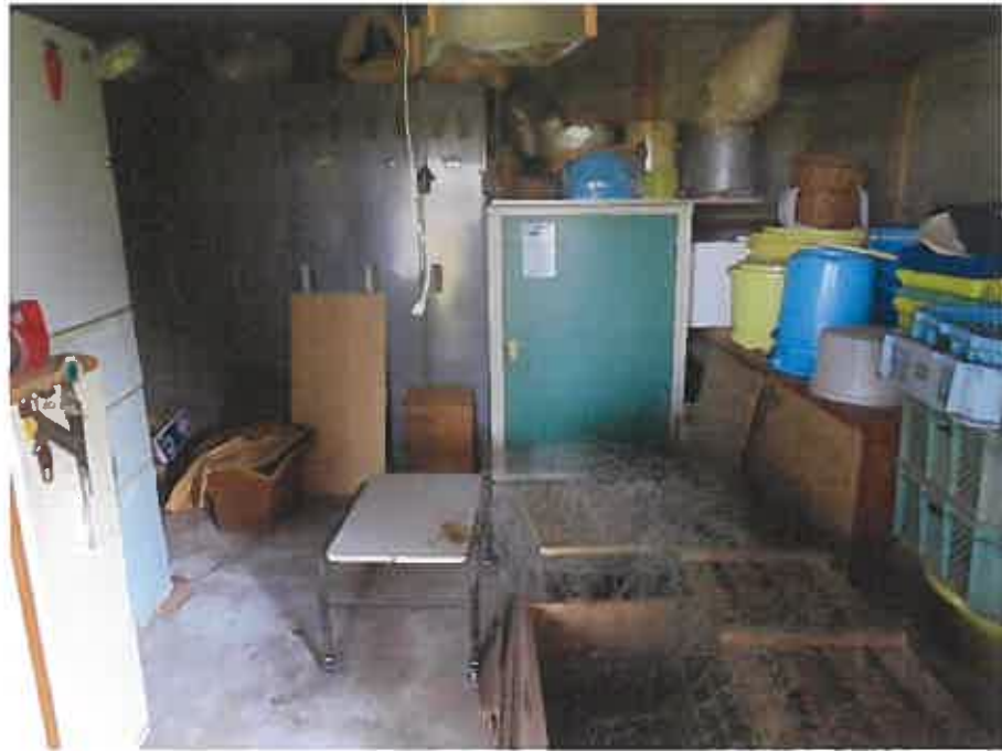
物件12未登記附属建物1:1階中央倉庫の状況
