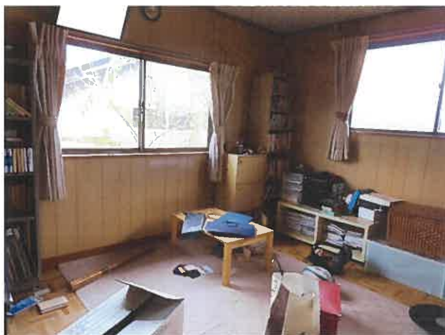
物件12未登記附属建物1:2階北側洋室の状況
