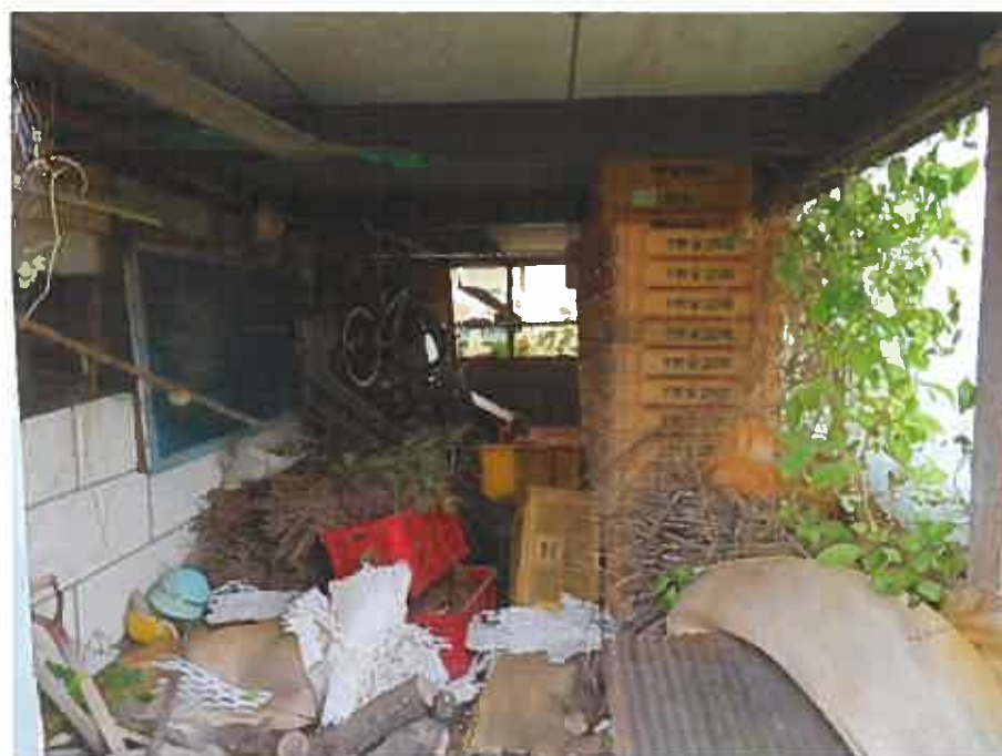
物件12未登記附属建物1:1階西側物置の状況
