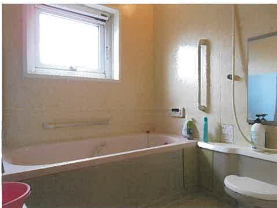
物件3:1階浴室の状況
