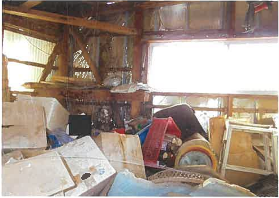
物件2：未登記附属建物(物置)の内部の状況
