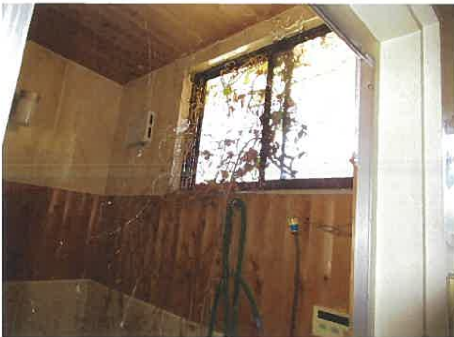
物件2:主である建物1階浴室の状況
