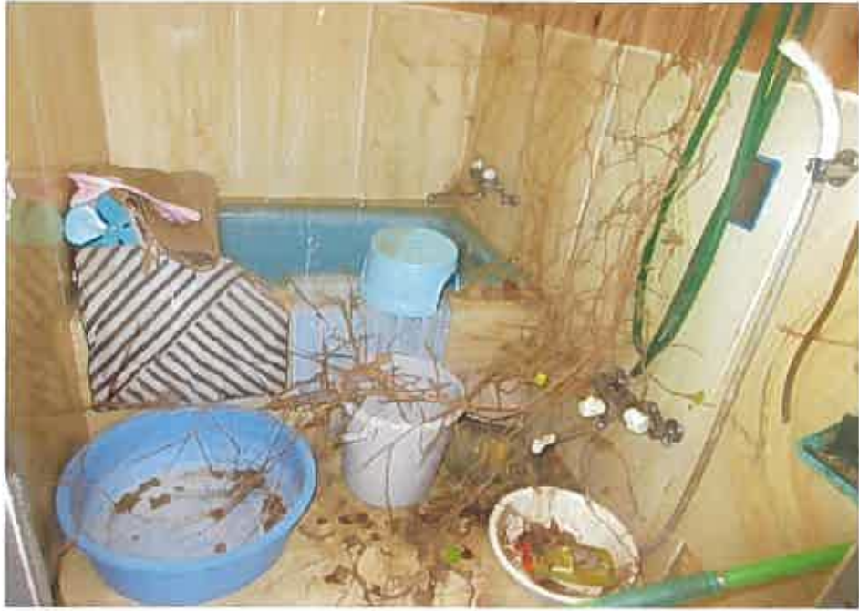
物件2:主である建物1階浴室の状況
