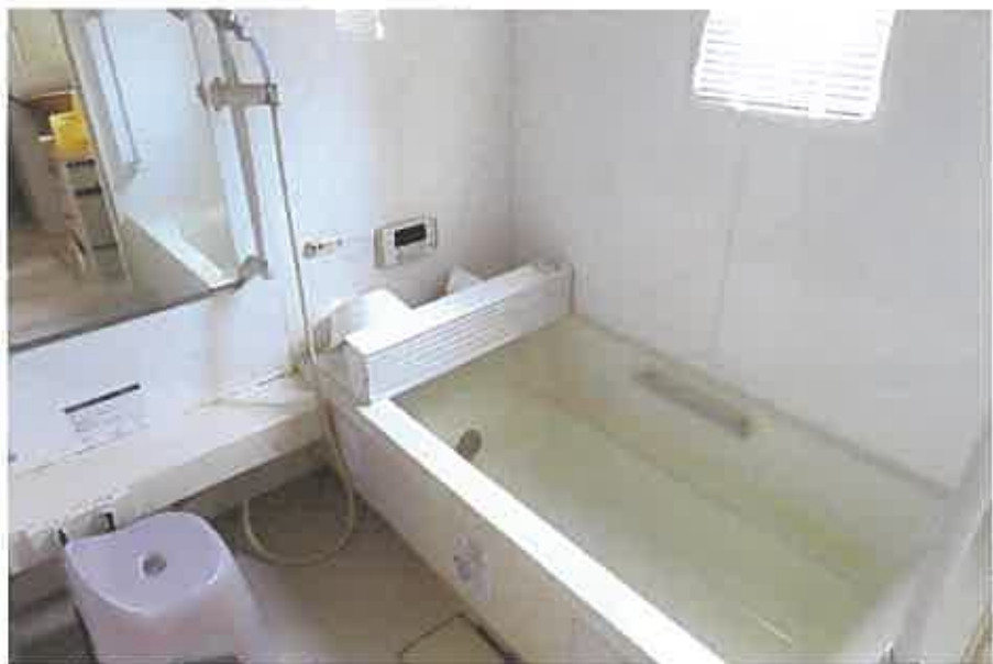
物件2:1階浴室の状況
