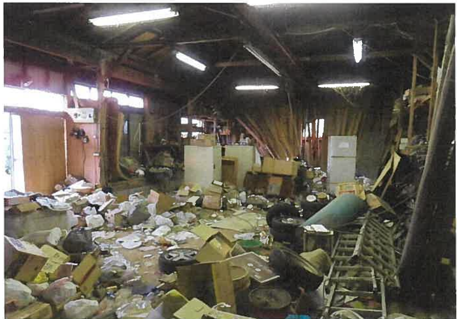
物件3附属建物符号1:南東側作業所の状況
