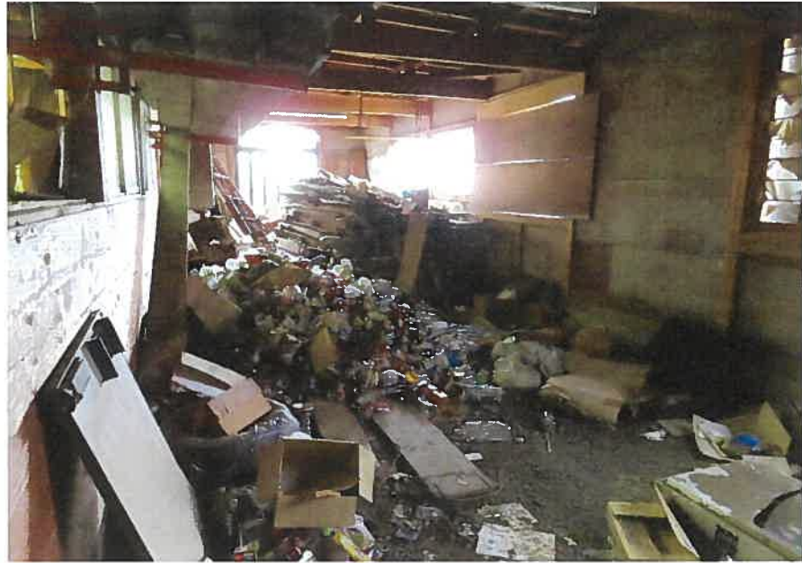
物件3附属建物符号1:北西側作業所の状況
