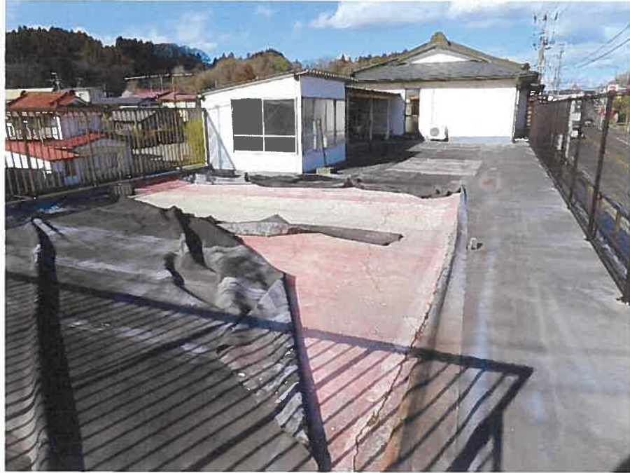
物件1, 2:車庫(工作物)屋根上の状況
