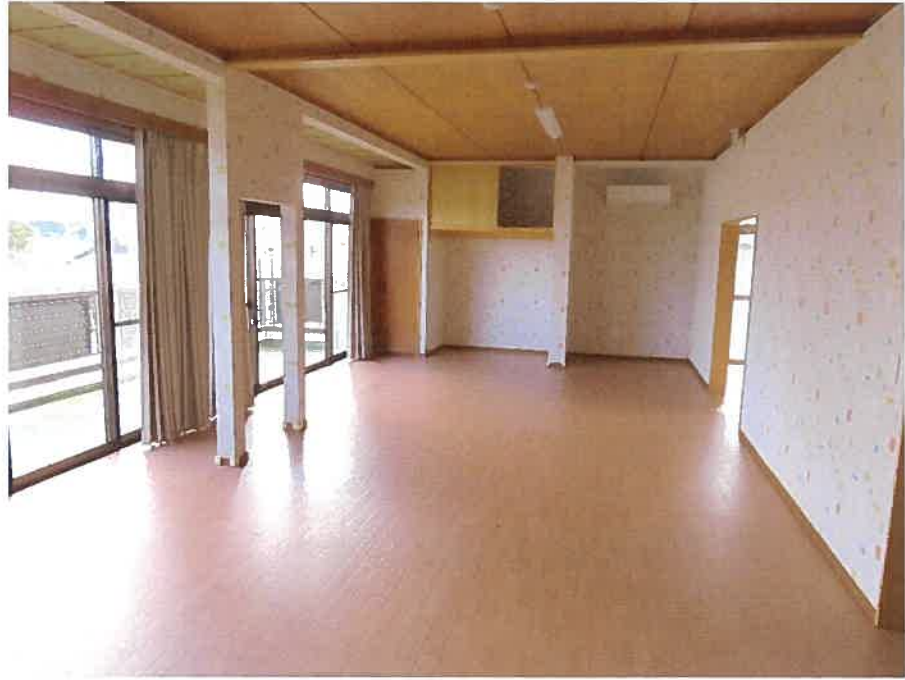
物件4:2階南側洋間の状況
