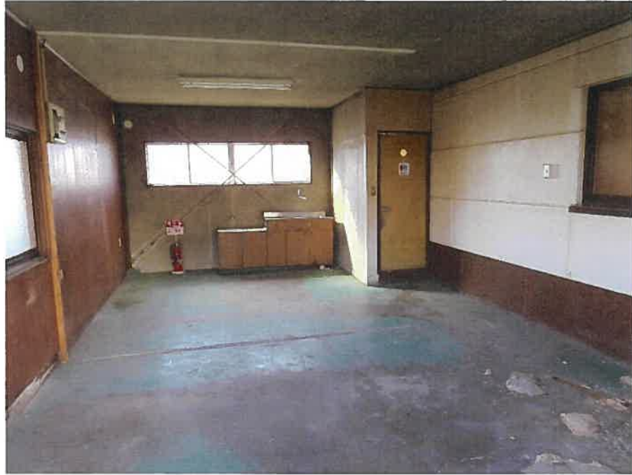
物件3: 運転手控室の状況
