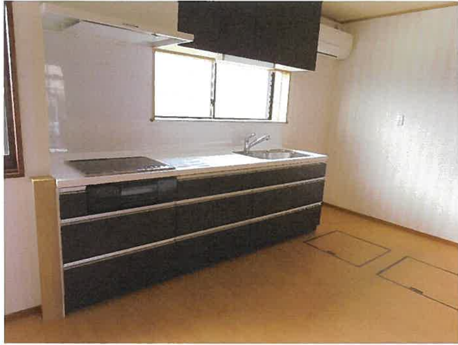
物件4:2階台所の状況
