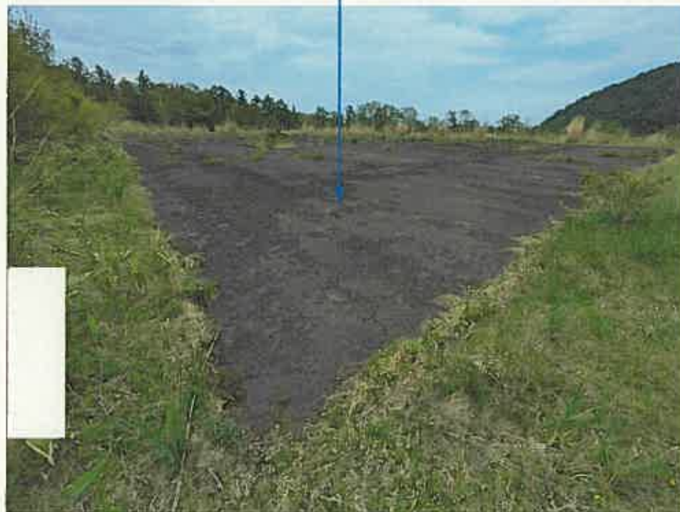
写 真 3 物件5 (アスファルト舗装(旧テニスコート)部分)
